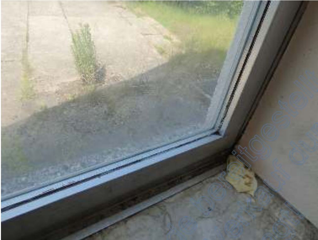
Bild 20: restliche Fenster mit Aluminiumrahmen und Doppelverglasung
