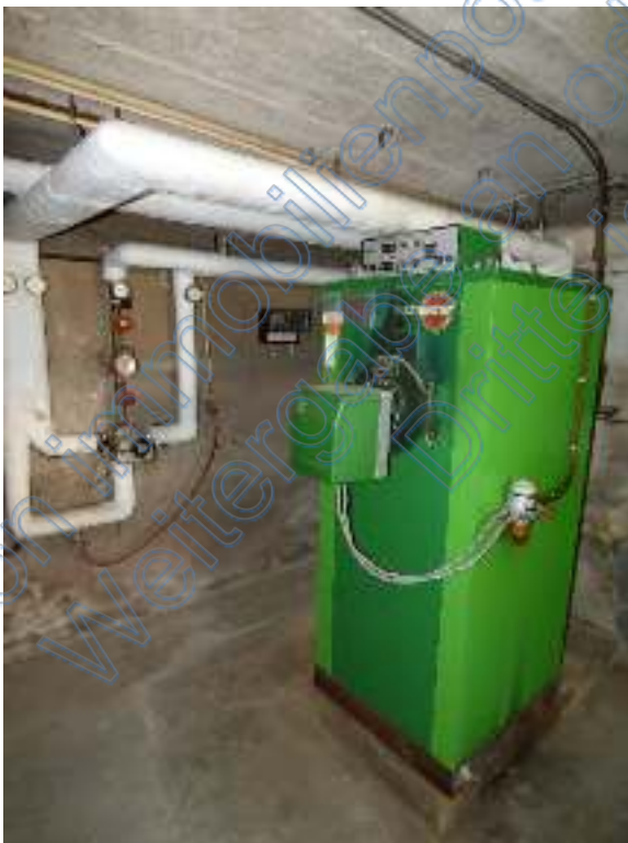
Bild 37: Ölzentralheizung
