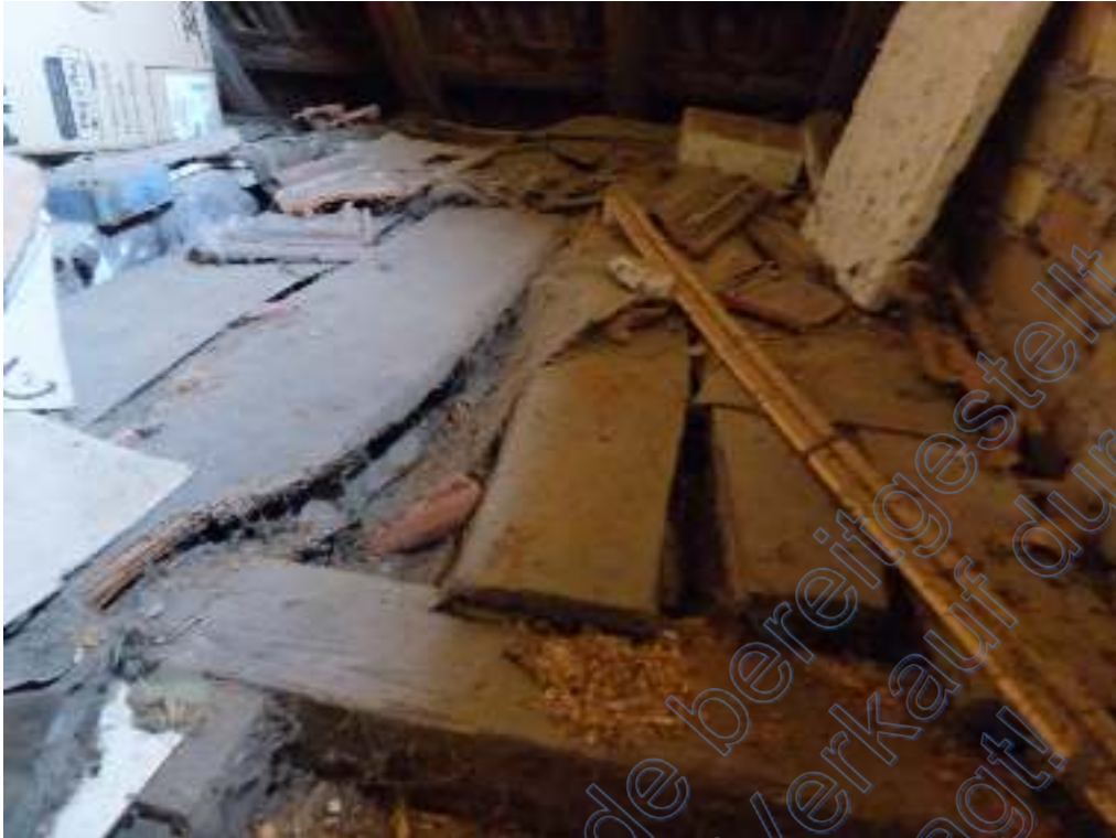
Bild 55: Decke vom Spitzboden
