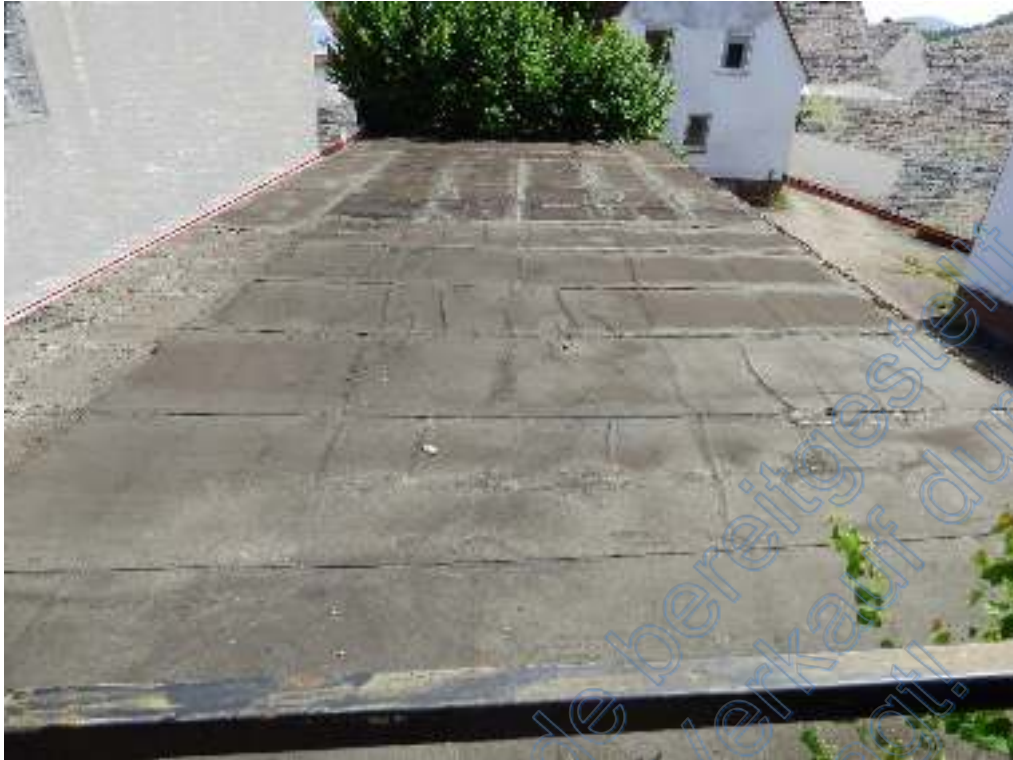
Bild 47: Dach Bereich Lager und Garage
