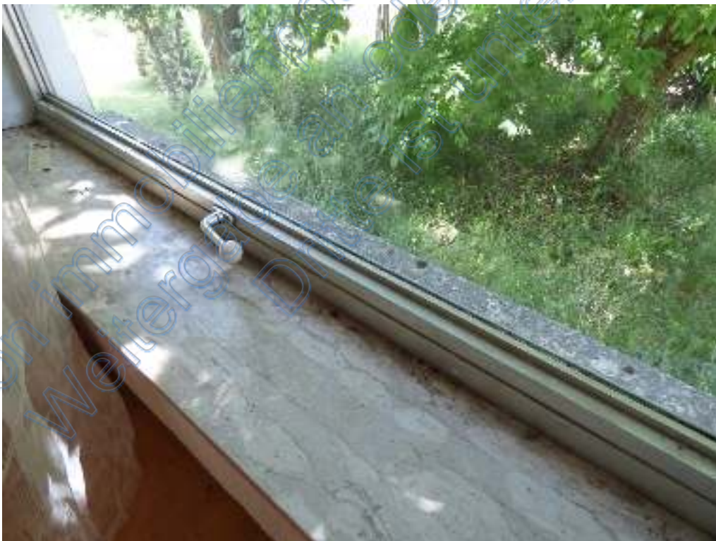
Bild 19: Fenster mit Aluminiumrahmen und Einfachverglasung in der Ansicht Süd
