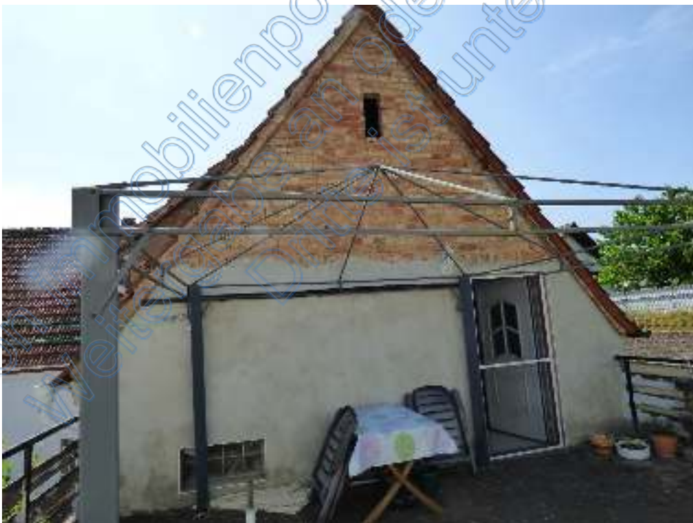
Bild 50: Ansicht Ost, Wohnbereich; Terrasse
