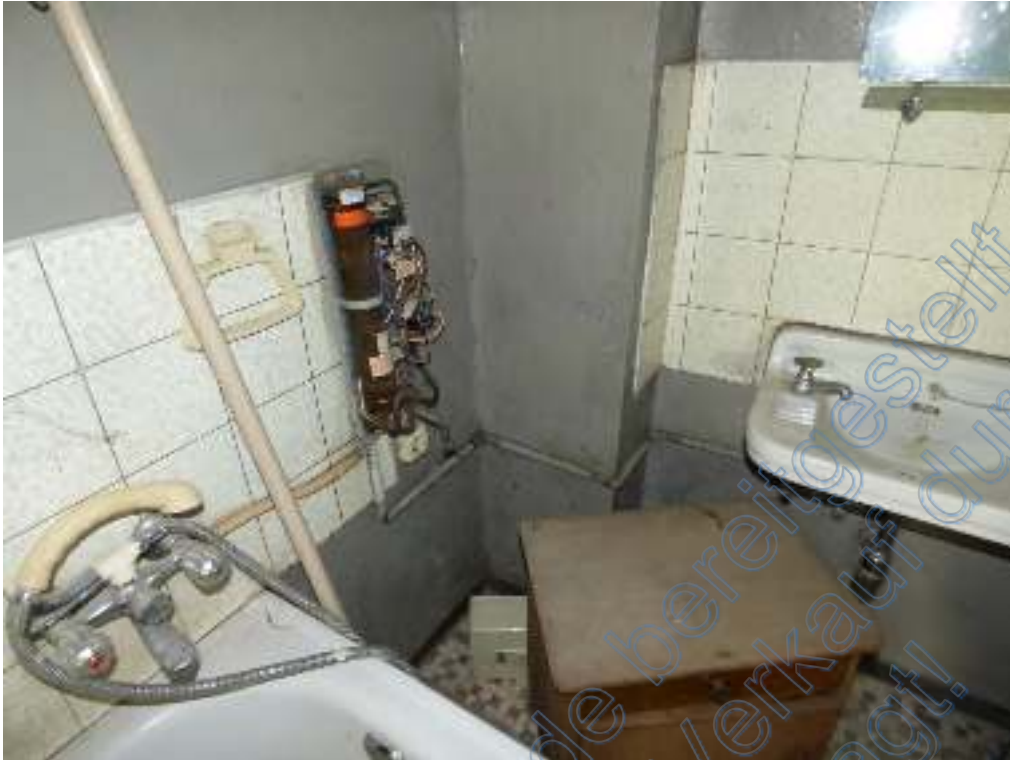
Bild 61: alter Elektrodurchlauferhitzer
