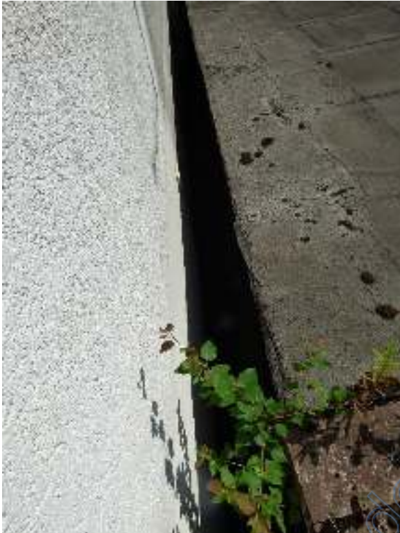
Bild 49: Luftraum zwischen Garage / Lager und dem Nachbargebäude
