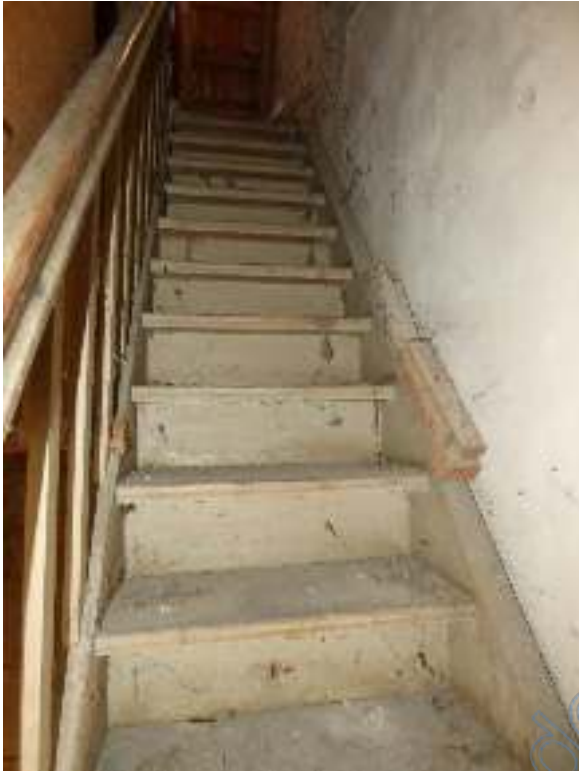
Bild 53: Treppenaufgang zum Spitzboden von der Küche vom Wohnbereich aus
