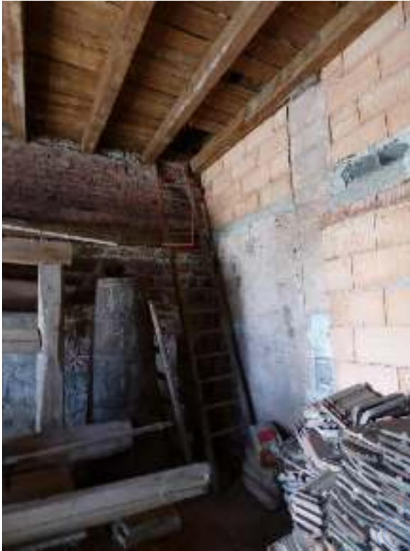
Bild 69: Zugang zum Scheunenboden (Bereich wurde nicht besichtigt)
