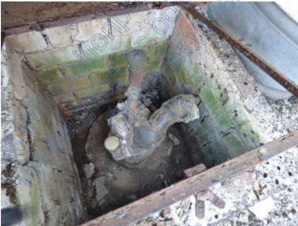
Bild 7: Erdtankanlage zum Betrieb des Vorderhauses; Tankvolumen unbekannt
