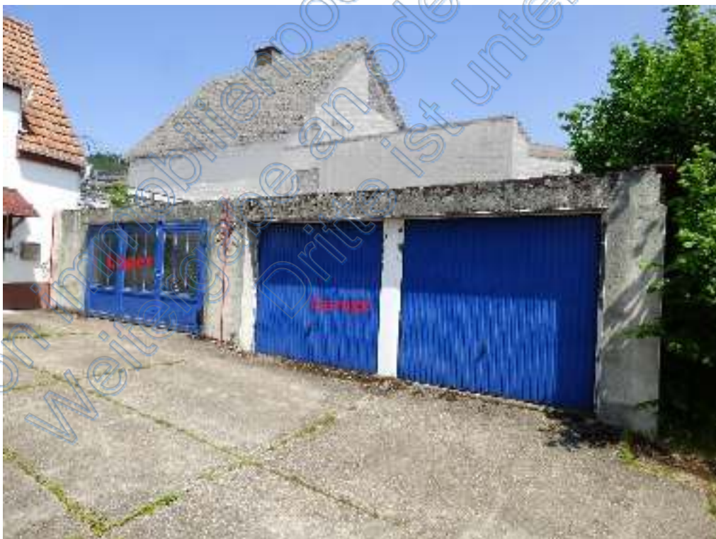
Bild 46: Ansicht West, Lager und Garage
