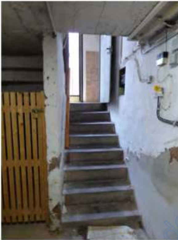
Bild 23: Kellerabgang im Innenbereich
