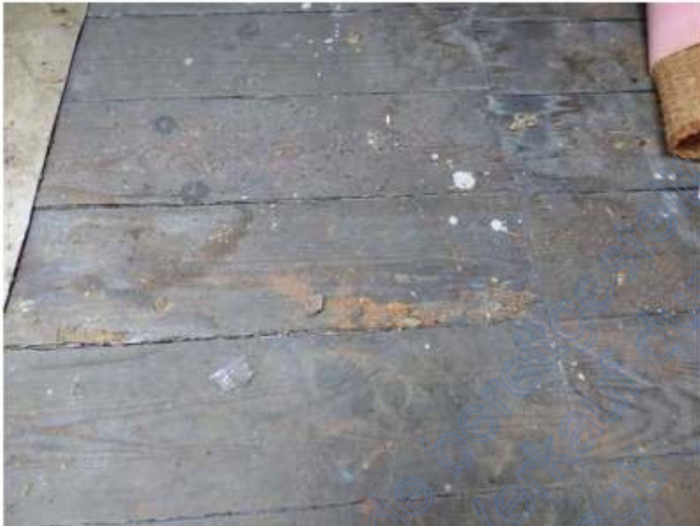
Bild 9: vereinzelt Holzwurm in der Dachbodenverkleidung
