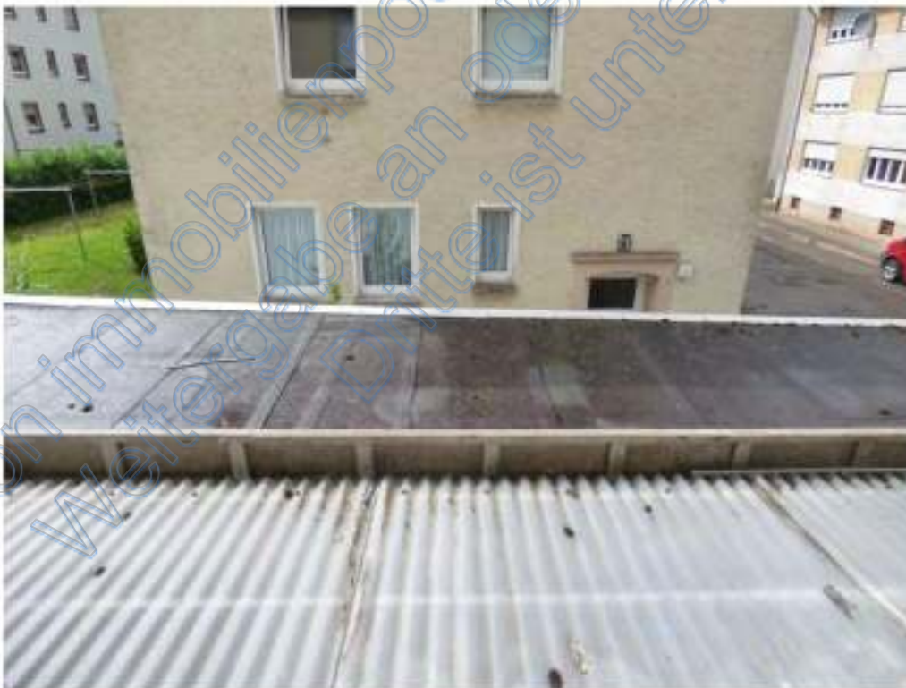
Bild 36: Eindeckung Garage (Bitumenbahnen) und Zugang zum Gebäude (Wellplatten)
