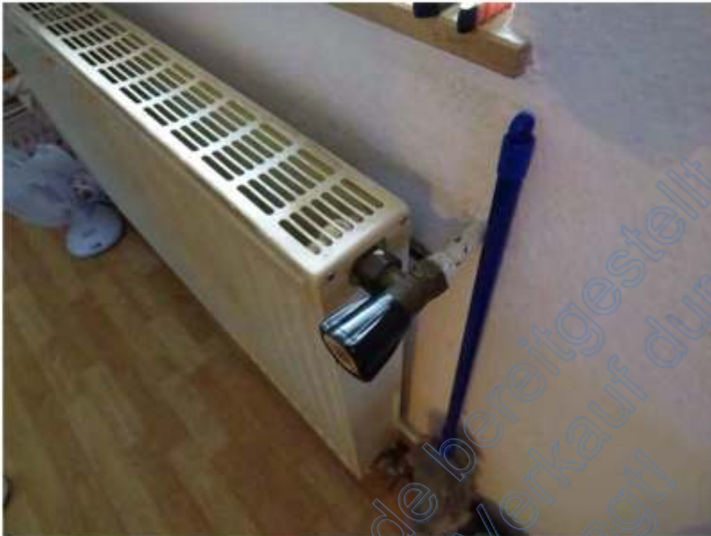
Bild 21: teilweise keine Thermostatköpfe
