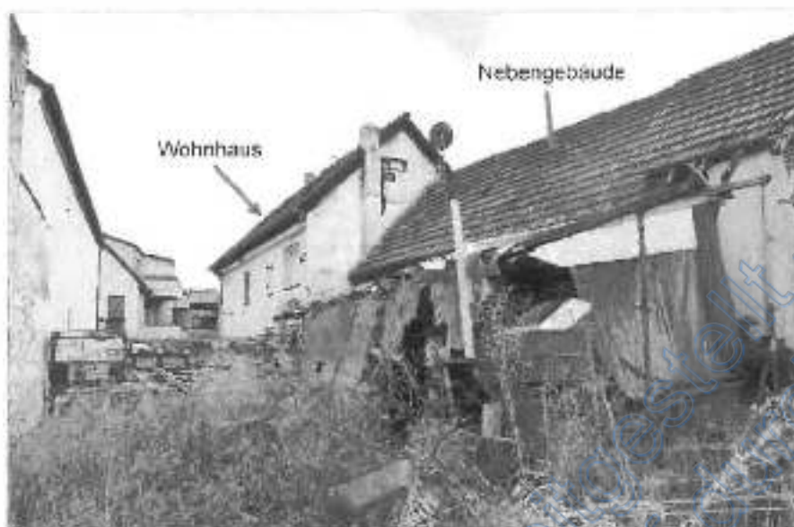
Ansicht aus Nordost
