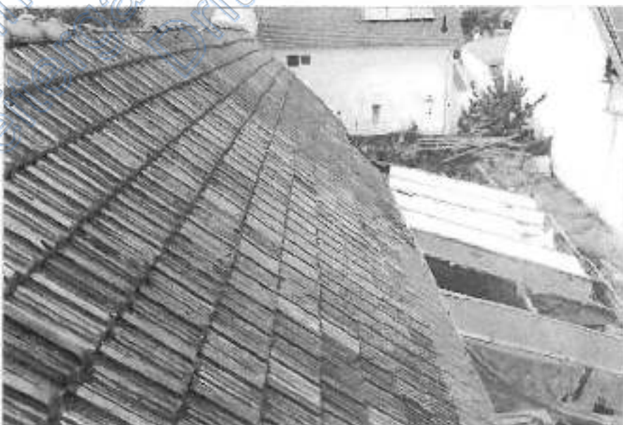
Blick über das Dach des Nebengebäudes nach Norden
