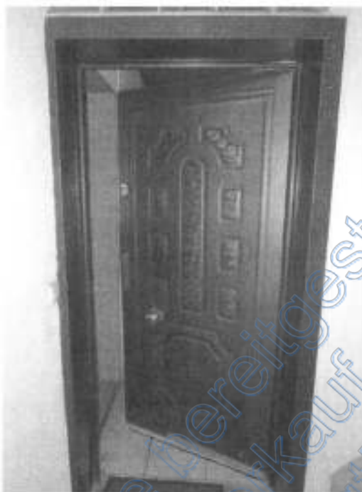
Bild 3: Eingang zur Wohnung Nr. 1 im Erdgeschoss
