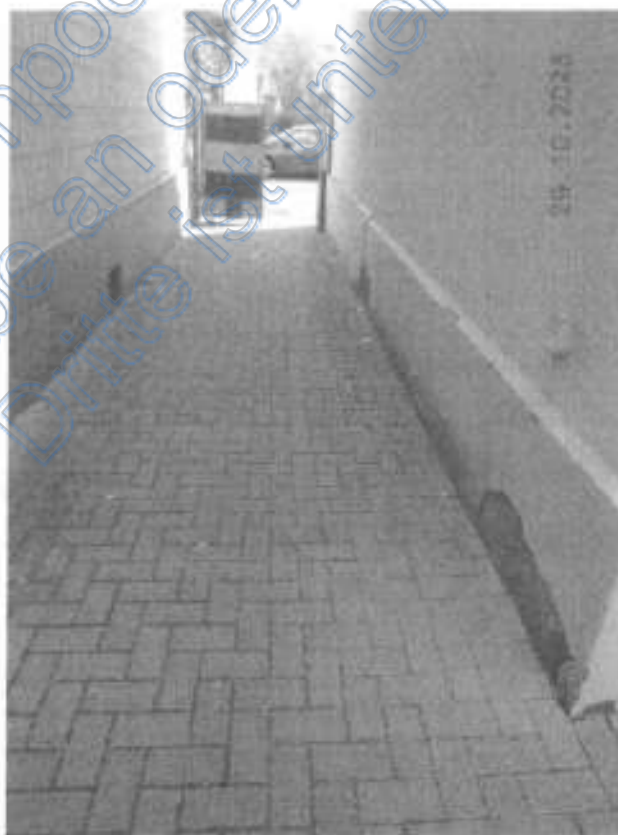
Bild 10: Zugang zum Hof
