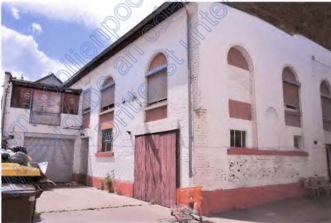
Ansicht Hinterhaus aus Ost/Nordost
