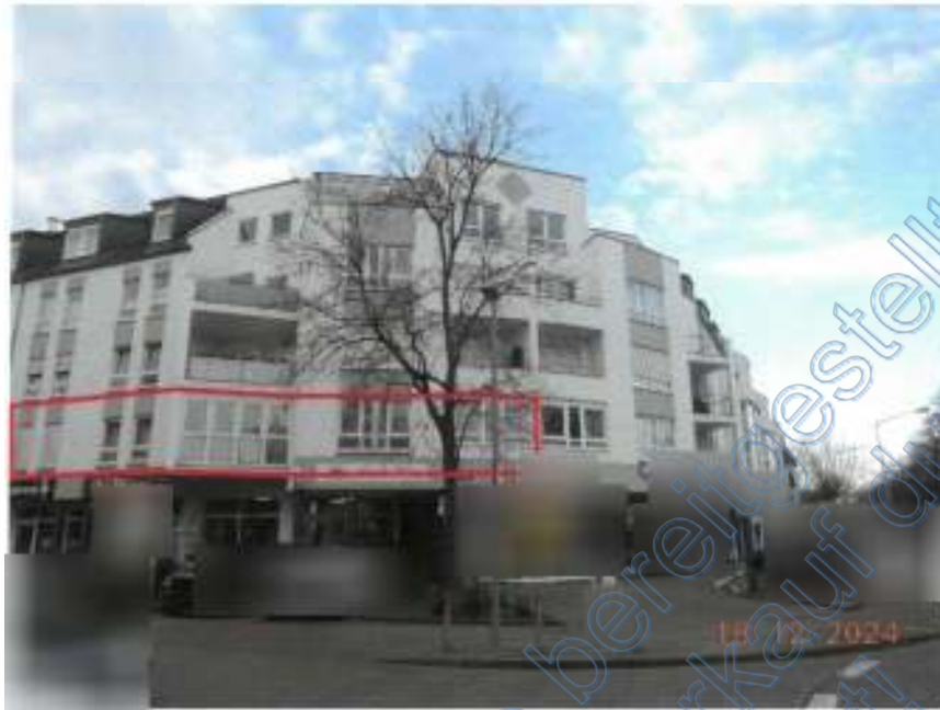
Bild 1: Gebäudeansicht von Nordosten mit rot markiertem Teileigentum im 1. Obergeschoss
