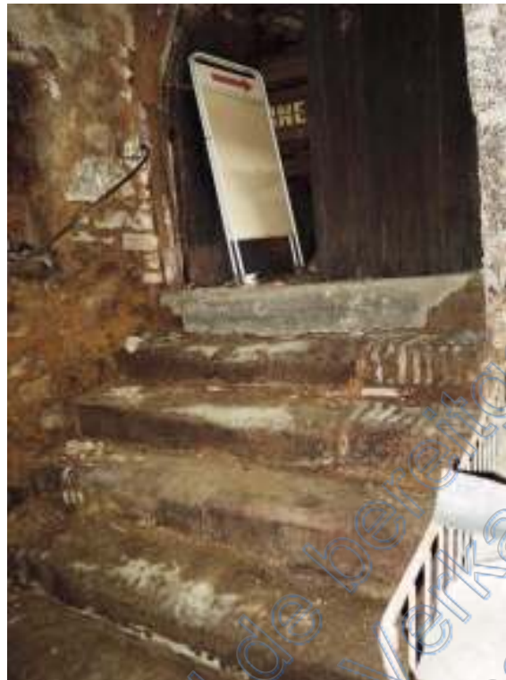
Abb. 31: Treppe zu den Gewölbekellern
