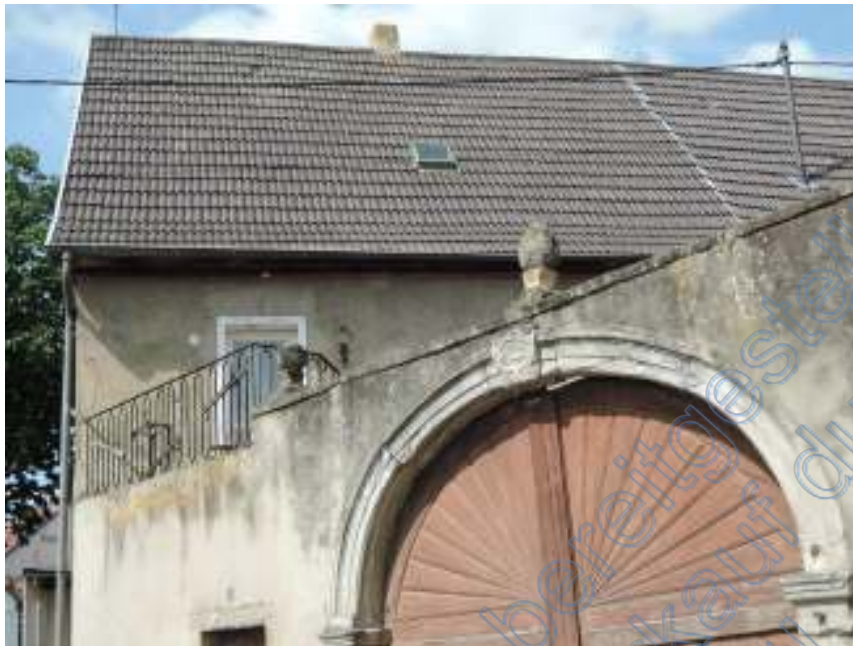
Abb. 1: Straßenansicht Eingangstor und Wohnhaus aus nordöstlicher Richtung
