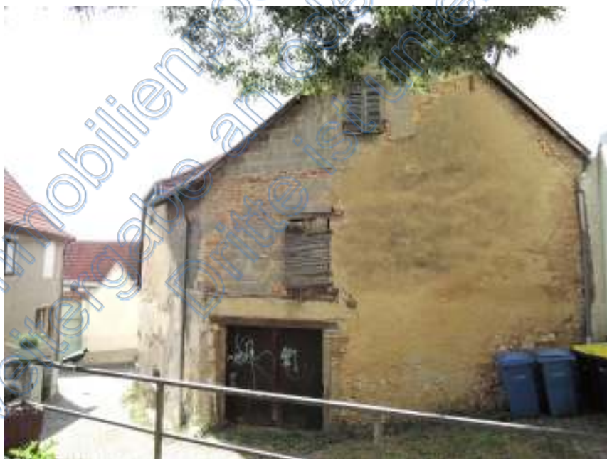
Abb. 4: Straßenansicht aus nördlicher Richtung (Ohligstraße)
