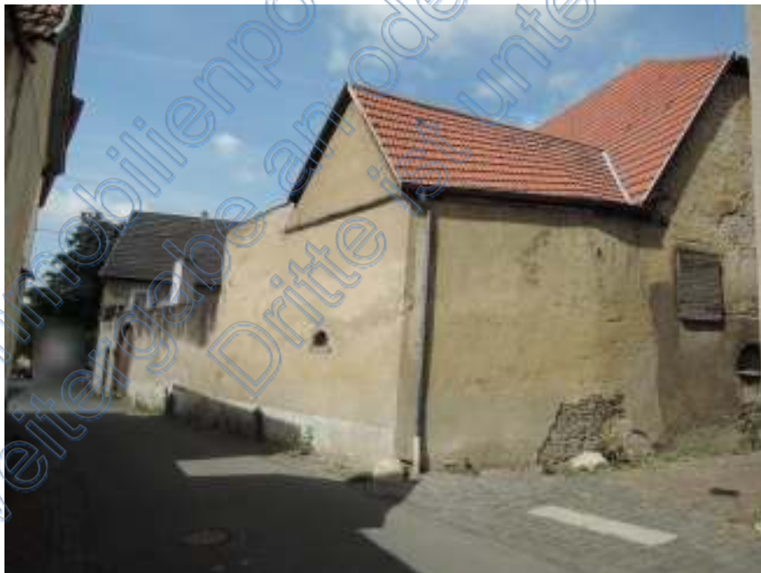
Abb. 2: Straßenansicht des Vierseithofs aus nordöstlicher Richtung (Seegasse, Ohligstraße)
