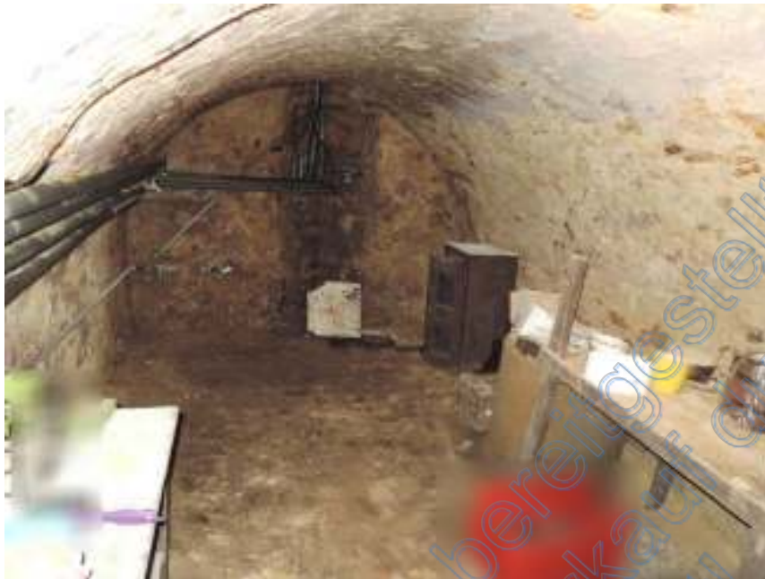
Abb. 21: Gewölbekeller im Wohnhaus
