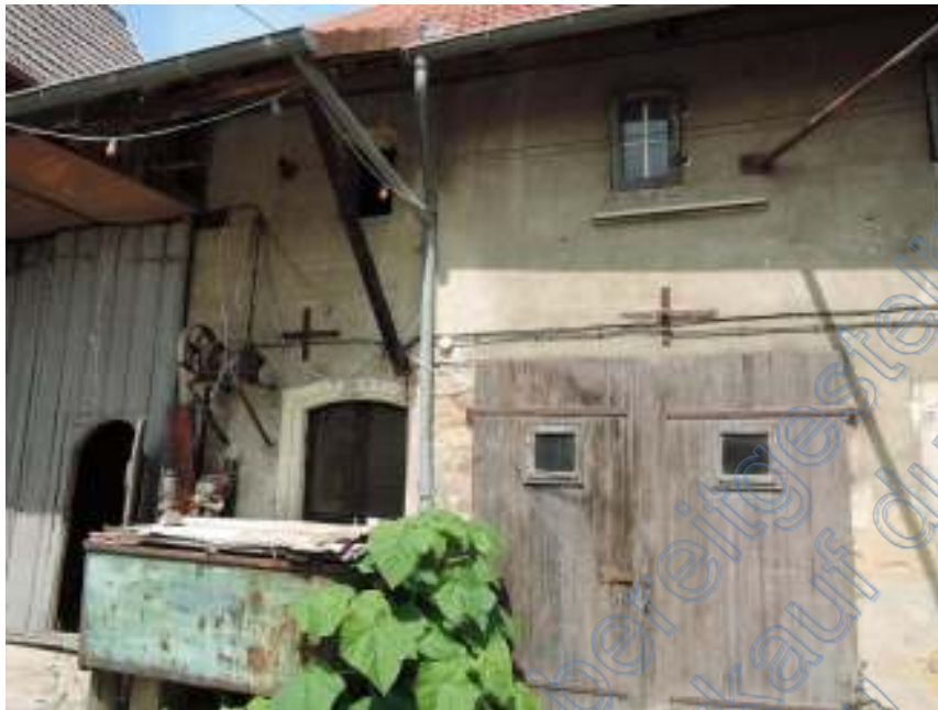
Abb. 7: Hofansicht der Scheune (1)
