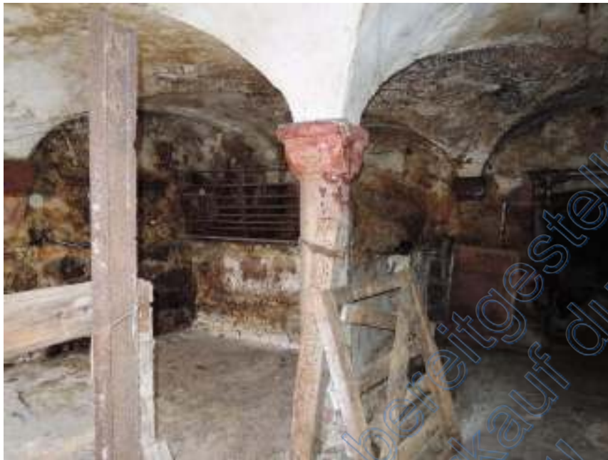
Abb. 25: Innenansicht des Gewölbestalls (2)
