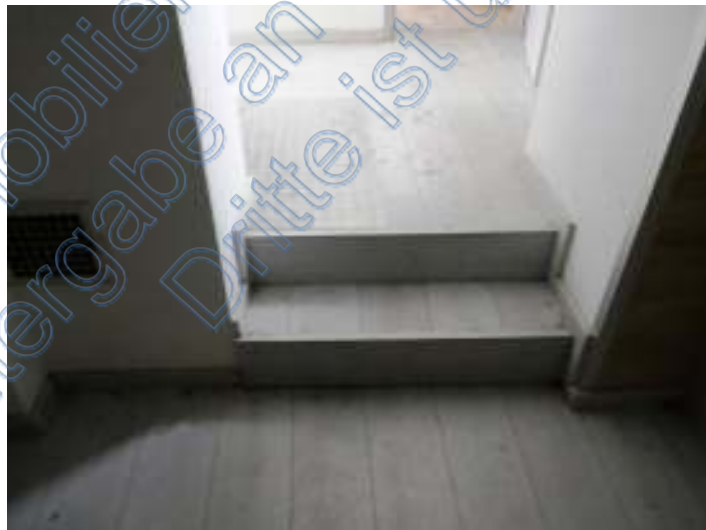
Abb. 6: Detailaufnahme 2 Stufen zum Anbau (Küche zum Flur)
