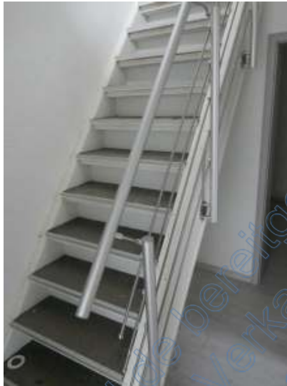
Abb. 9: Treppe zum Dach- bzw. Obergeschoss
