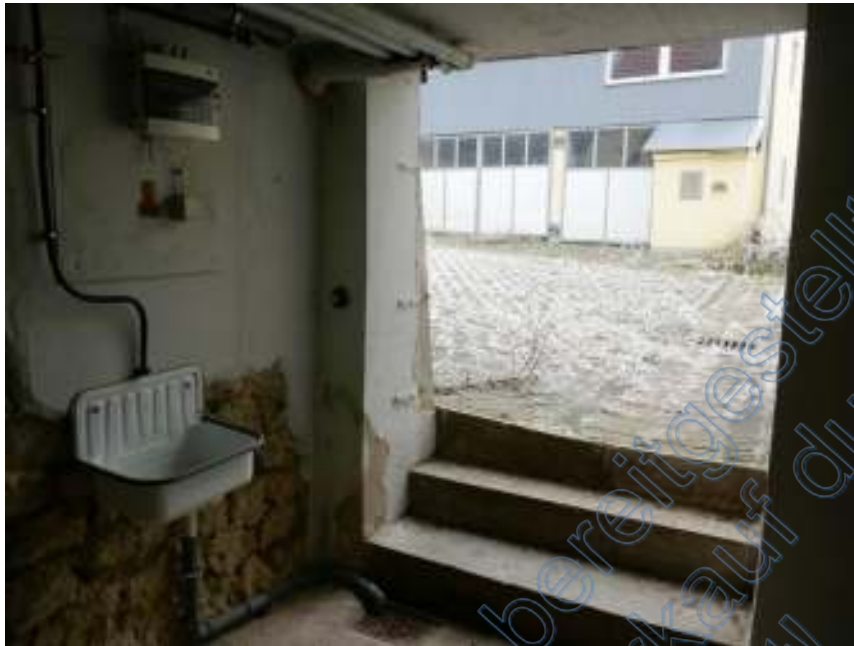
Abb. 13: Waschküche im Untergeschoss des Anbaus
