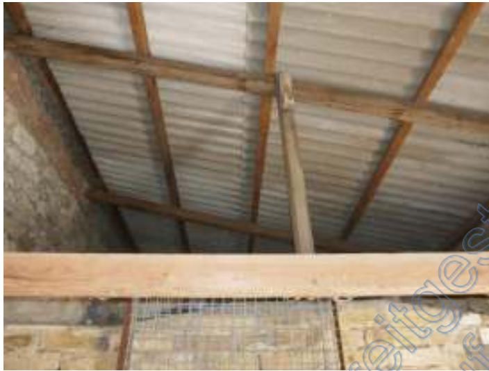
Abb. 25: Innenansicht Dach des seitlichen Anbaus an die Scheune
