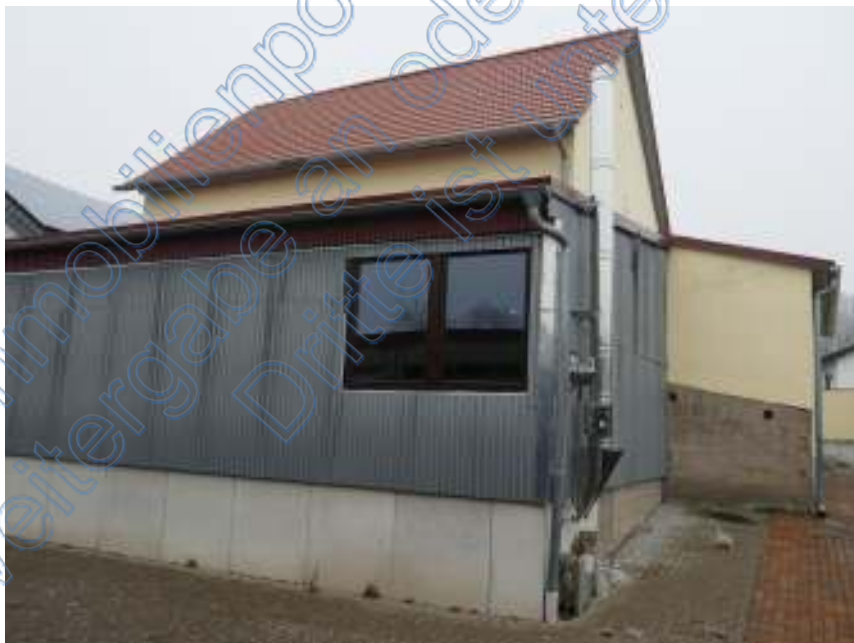
Abb. 20: Rückansicht der Scheune mit seitlichem Anbau und rückseitigem Anbau
