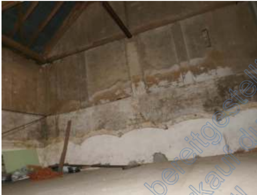
Abb. 19: Innenansicht der Scheune
