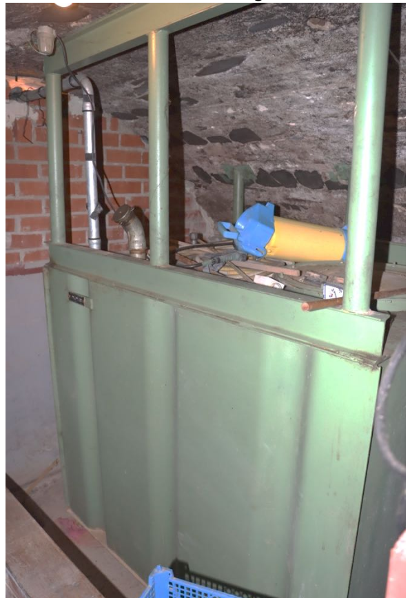
Öltank mit Auftriebsicherung
