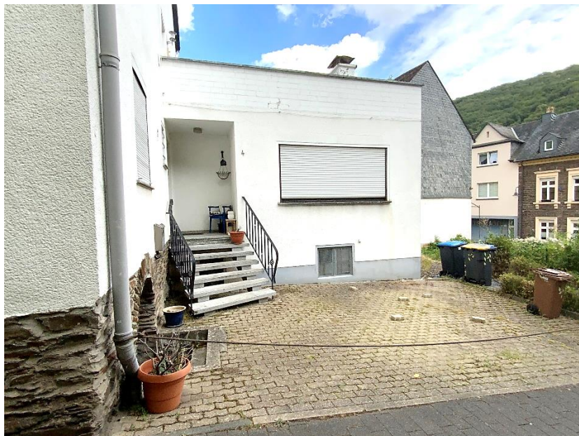
Bild 2 : Blick auf den Anbau, den Eingangsbereich, den Kellerzugang (links) und die befestigte Stellplatzfläche
