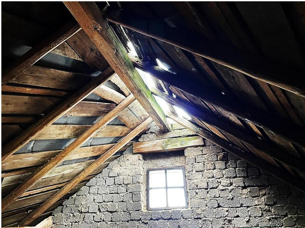
Bild 12: fehlende Dachbekleidung im südlichen Firstbereich des Anbaus
