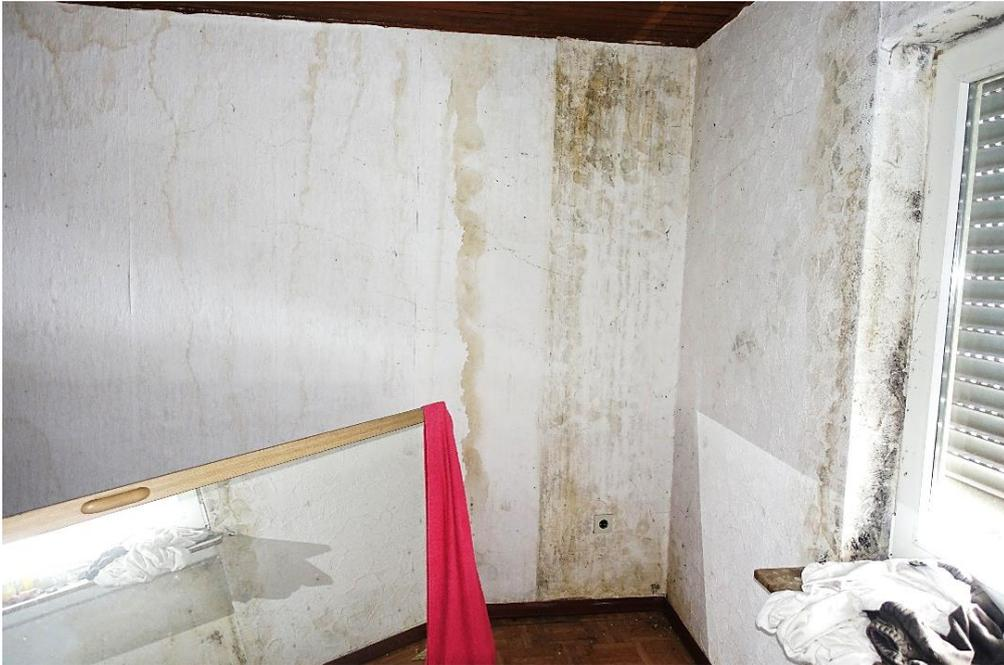
Bild 9: durchfeuchtete Wand aufgrund der schadhaften Dachhaut (s. Bild Nr. 12)
