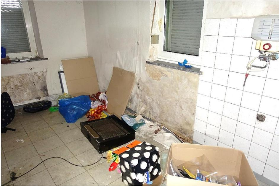
Bild 13: Küche im Erdgeschoss des Haupthauses mit Feuchtigkeitsschäden im Wandbereich
