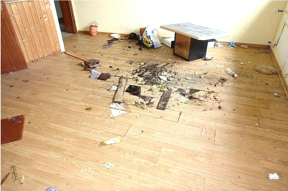
Bild 11: Schädigung des Bodens aufgrund des schadhaften Daches
