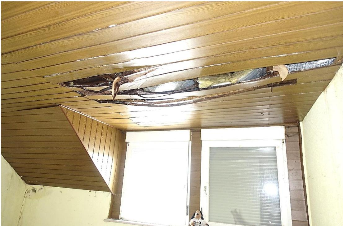
Bild 10: Feuchtigkeitsschäden aufgrund des schadhaften Daches
