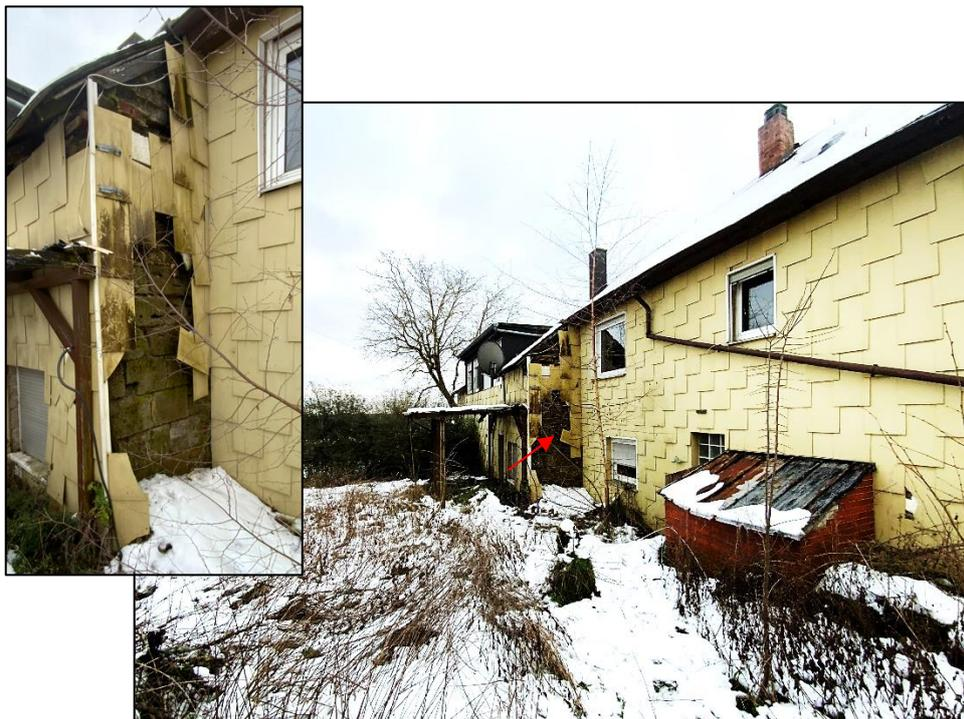
Bild 4: Blick auf die rückseitige Fassade von Norden mit schadhafter Außenverkleidung des Gebäudes und erheblicher Durchfeuchtung des Mauerwerks
