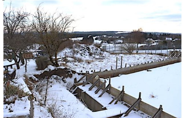
begonnene Baumaßnahme hinter dem Gebäude
