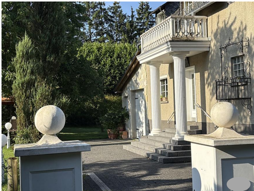
Bild 5: gartenseitiger Eingangsbereich des Wohnhauses und Anbau (links) von Norden
