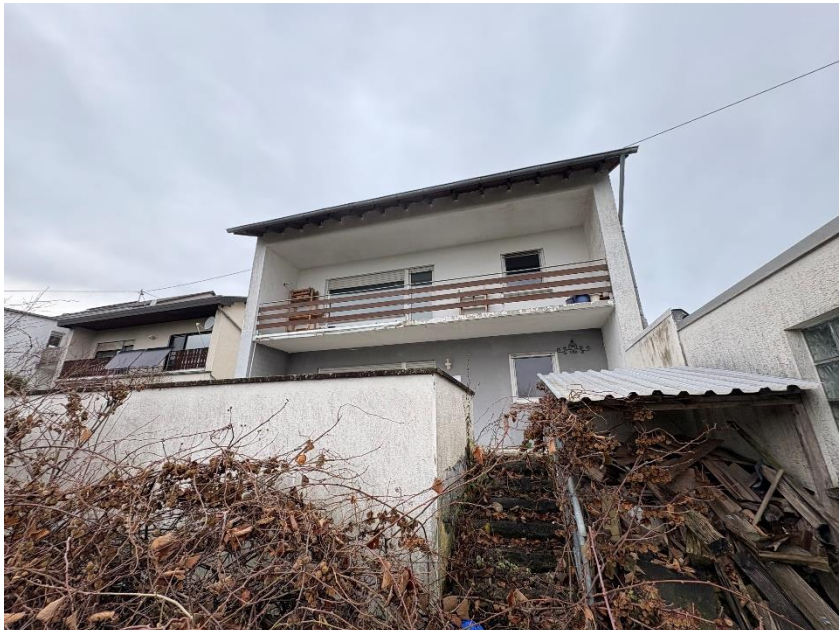
Bild 3: rückseitige Gebäudeansicht mit Zugang zur Terrasse
