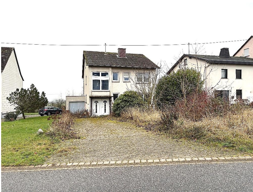
Bild 1: straßenseitige Ansicht des Bewertungsobjekts von Norden
