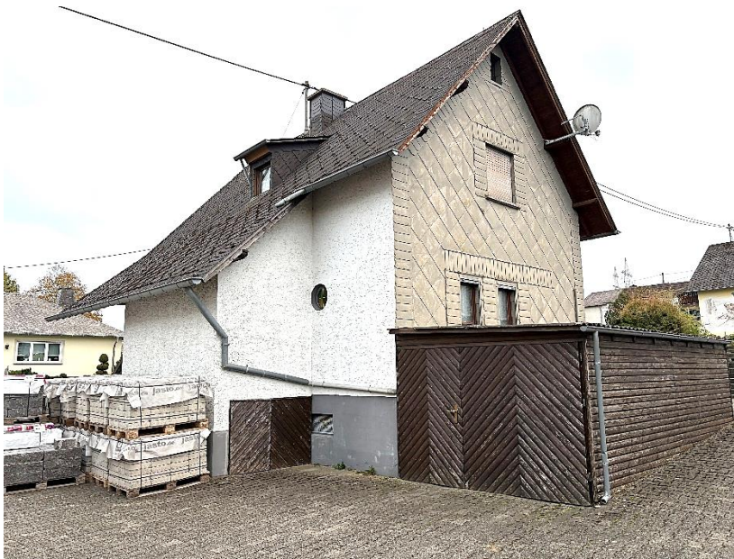
Bild 3: rückseitige Gebäudeansicht mit Holzbretterschuppen (Überbau)
