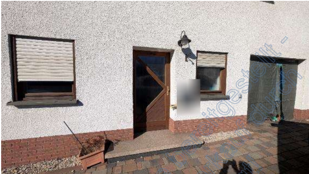
Bild B5: exemplarische Ansicht Gebäudeeingang
