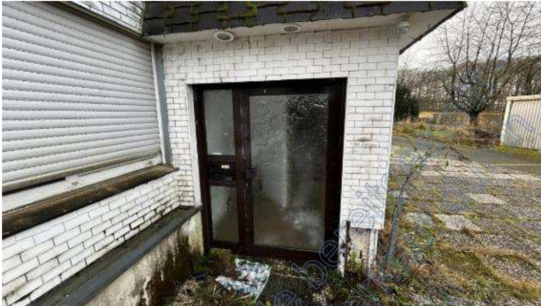
Bild B9 Eingang Gebäuderückseite
