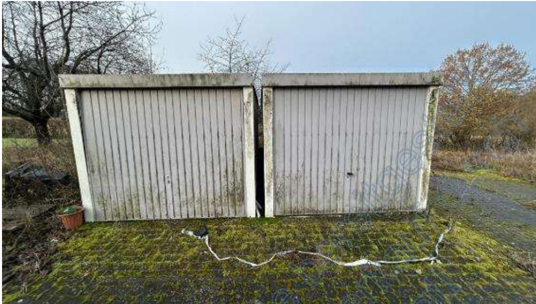
Bild B15 Fertiggaragen
