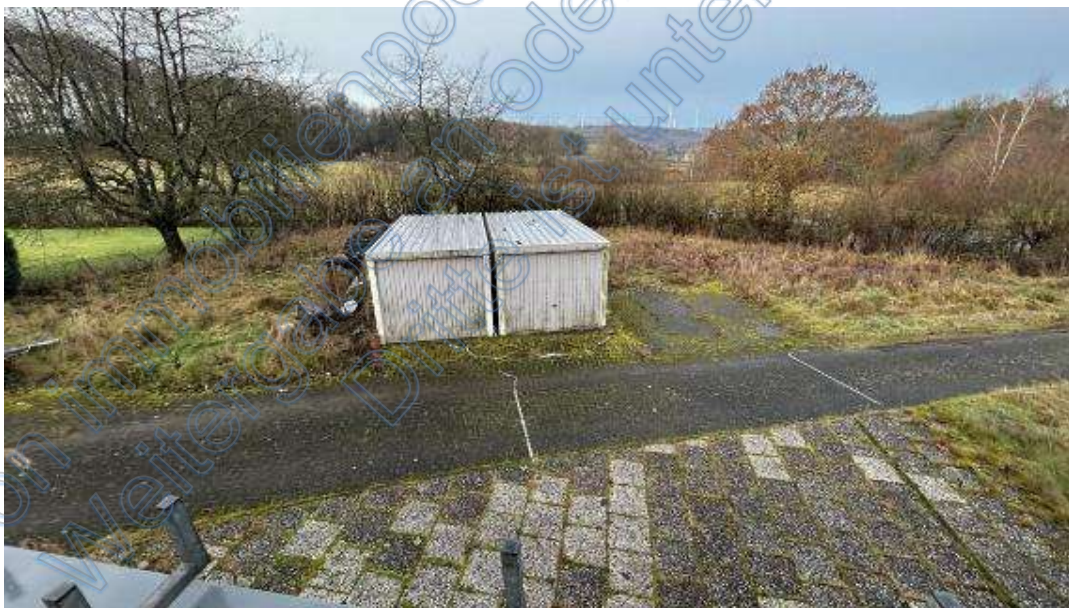
Bild B14 Fertiggaragen
