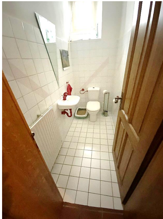
Bild 5: Blick vom Flur in das Gäste-WC (EG)
