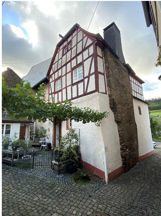
Bild 3: Blick auf den Giebel und den Zugangsbereich zum Grundstück
