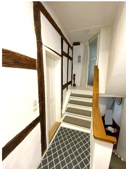
Bild 7: Treppe vom Ober- zum 2. Obergeschoss mit Zugangstür zur Einliegerwohnung
