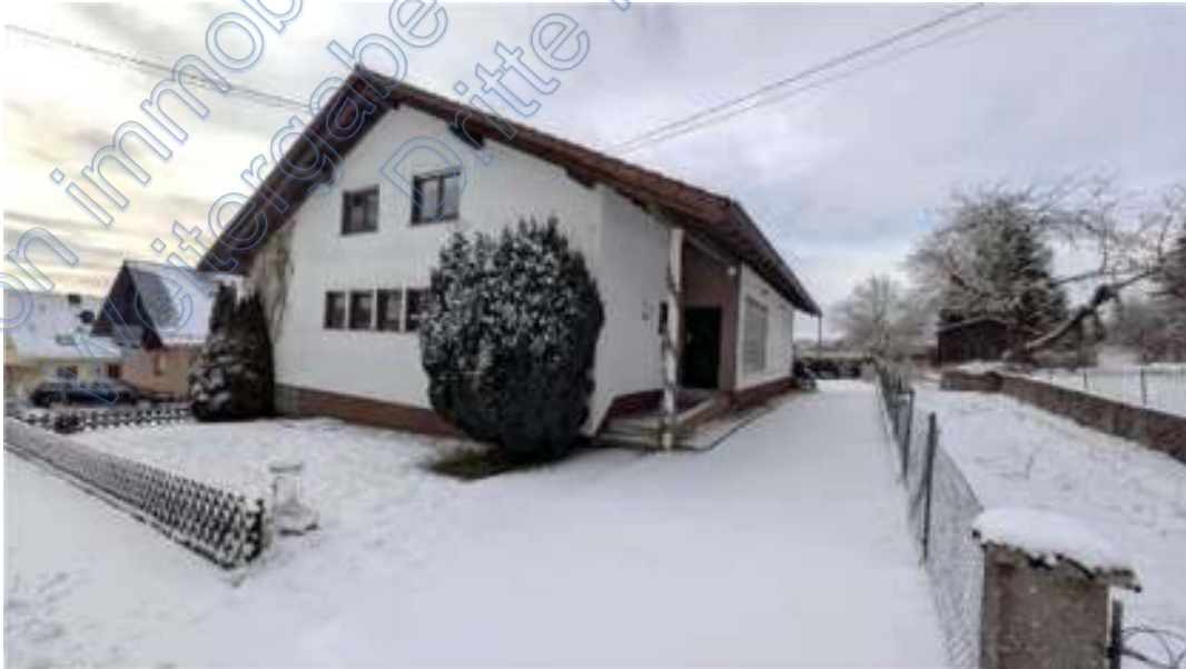
Bild B1 exemplarische Gebäudeansicht
