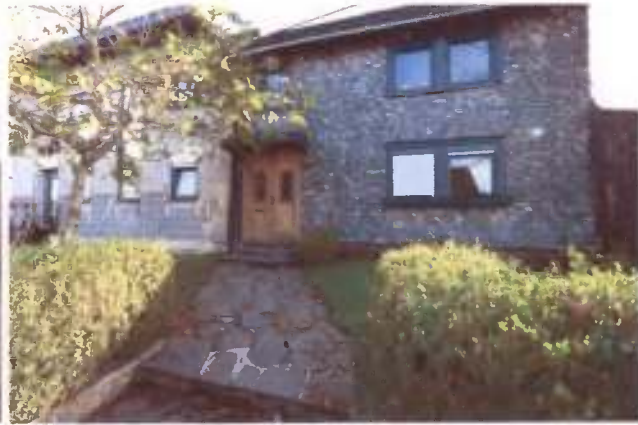
Foto 8: Straßenansicht Altbau aus Westen
