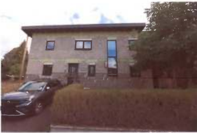
Foto 3: Straßenansicht Neubau aus Westen
