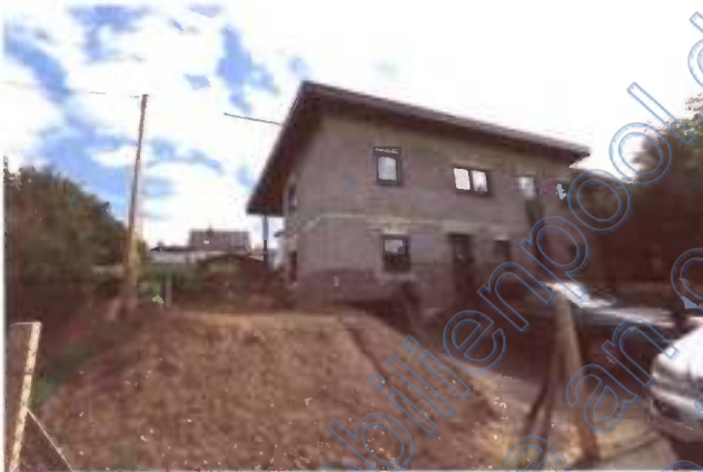
Foto 5: Ansicht aus Nord-Westen
