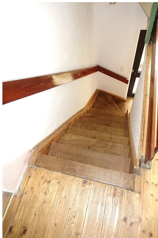
Bild 6: Treppe vom Ober- zum Erdgeschoss
