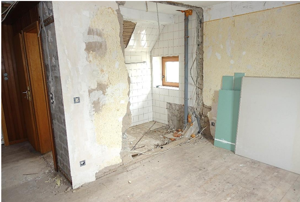
Bild 11 : Zimmer im Dachgeschoss mit Durchbruch zum Nebenraum (ehemaliges Bad)
