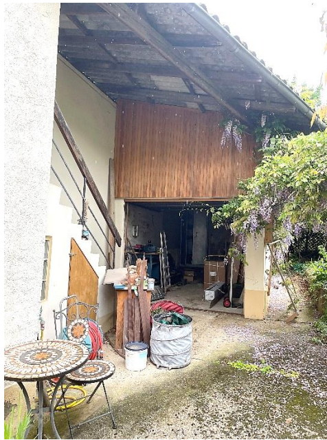
Bild 3: Blick auf das Garagengebäude und die Außentreppe vom Hof zum OG des Wohnhauses
