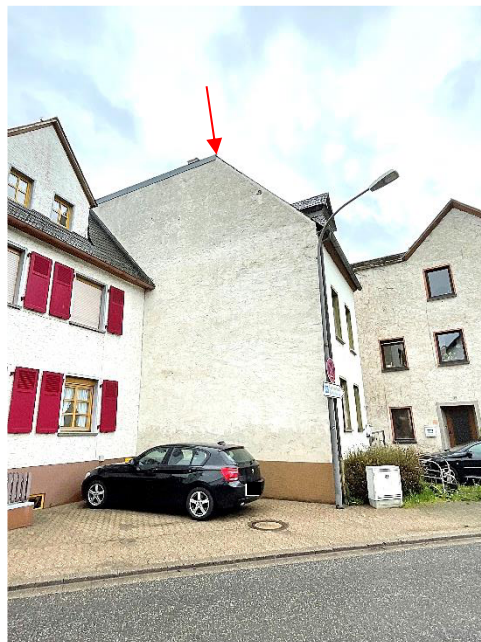
Bild 2: straßenseitiger Blick auf die nordöstliche Außenwand des Wohnhauses
