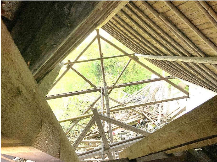
Bild 5: Blick vom Dachgeschoss des Hauptgebäudes auf den eingestürzten nördlichen Gebäudeteil
