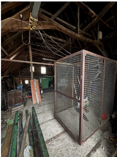
Bild 15: Abstellraum im Erdgeschoss
