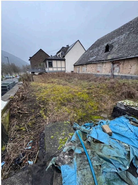
Bild 13: Dachterrasse im Erdgeschoss
