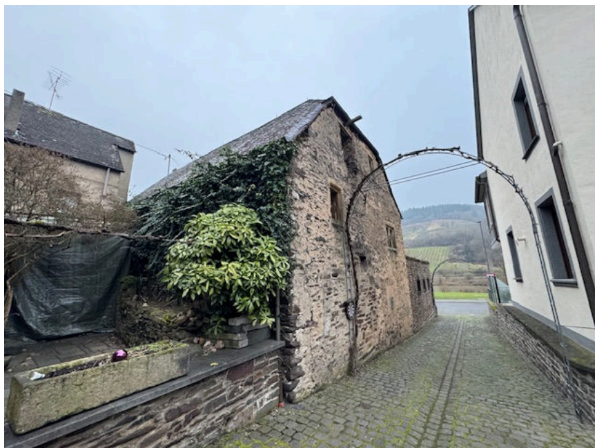
Bild 4: Rückansicht des Bewertungsobjekts aus nordwestlicher Richtung
