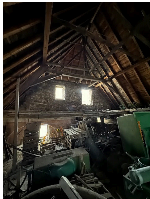
Bild 16: Abstellraum im Erdgeschoss
