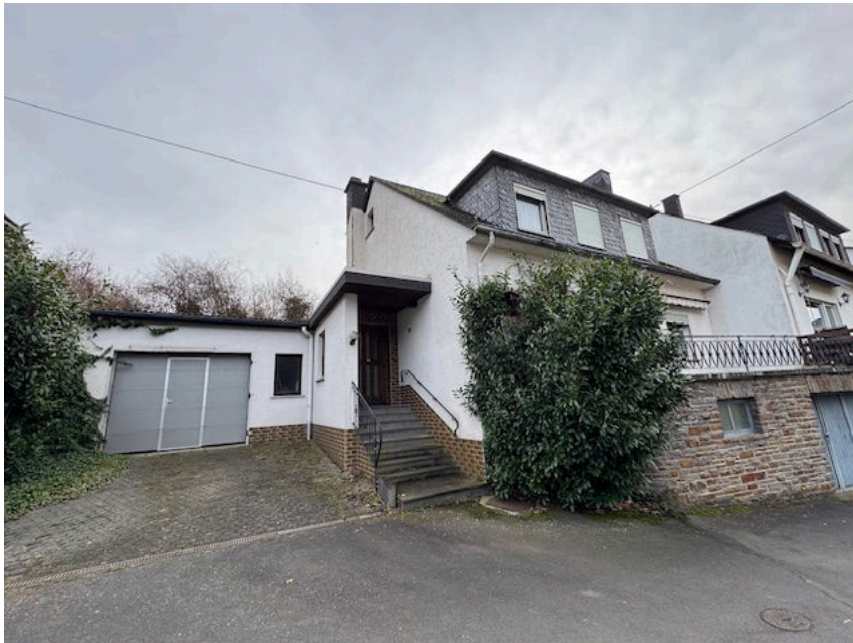
Bild 1: Straßenansicht des Bewertungsobjekts aus nordwestlicher Richtung
