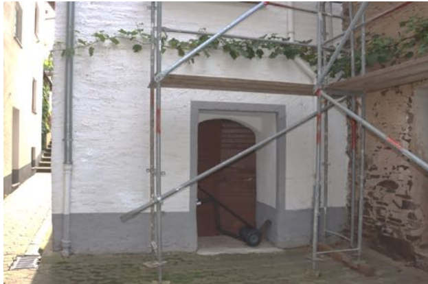
Rückansicht und Kellereingang
