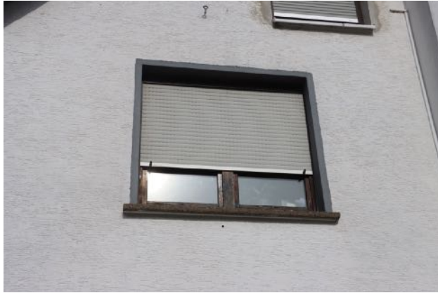
Details Fassade und Fenster
