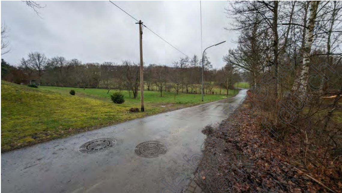
Bild A3 exemplarische Blick in die Erschließungsstraße
