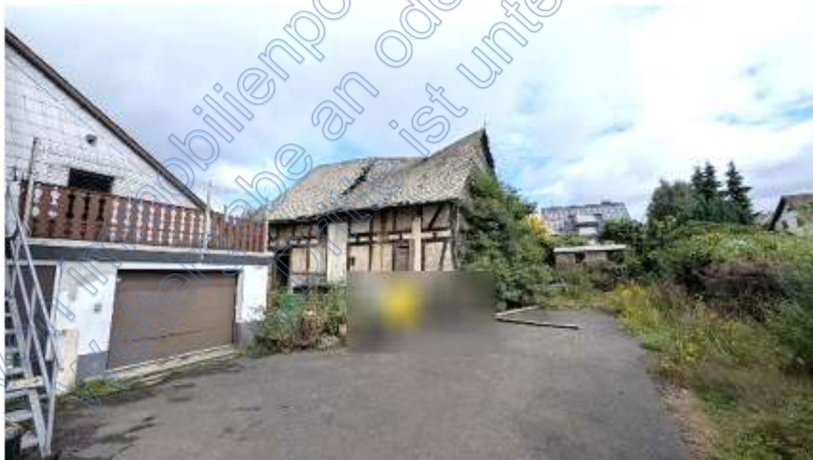
Bild B6 Scheune mit Garage
