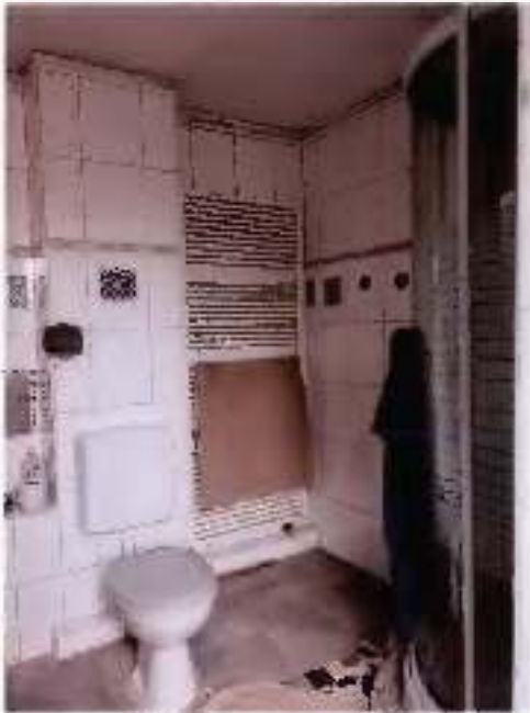
Bild 15: Bad im OG (3)
