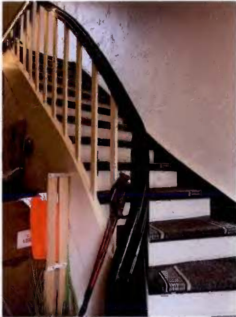
Bild 7: Flur mit Treppe im EG (3)
