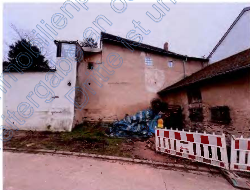
Bild 6: Rückansicht des Bewertungsobjekts aus nordwestlicher Richtung
