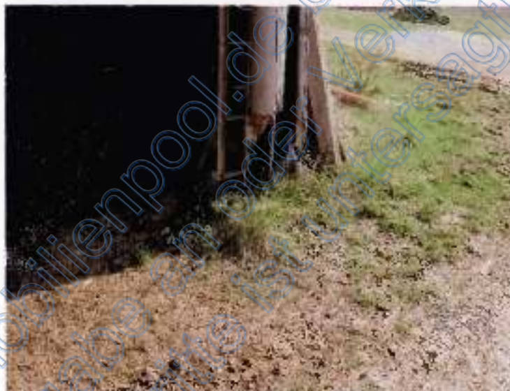
Foto 12 – Wandpfosten angefault
