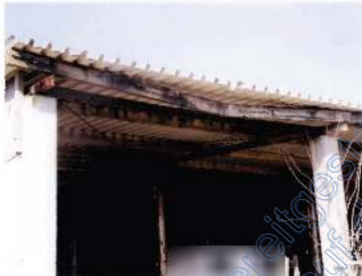
Foto 8 – Einbruch Koppelpfetten
