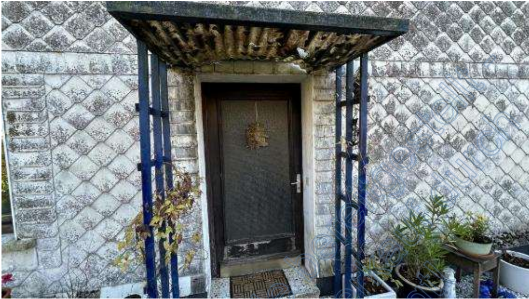
Bild B5 Gebäudeeingang Kellergeschoss
