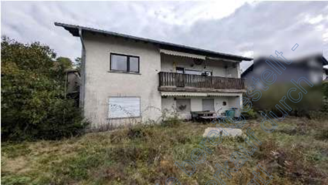
Bild B4 Gebäuderückseite
