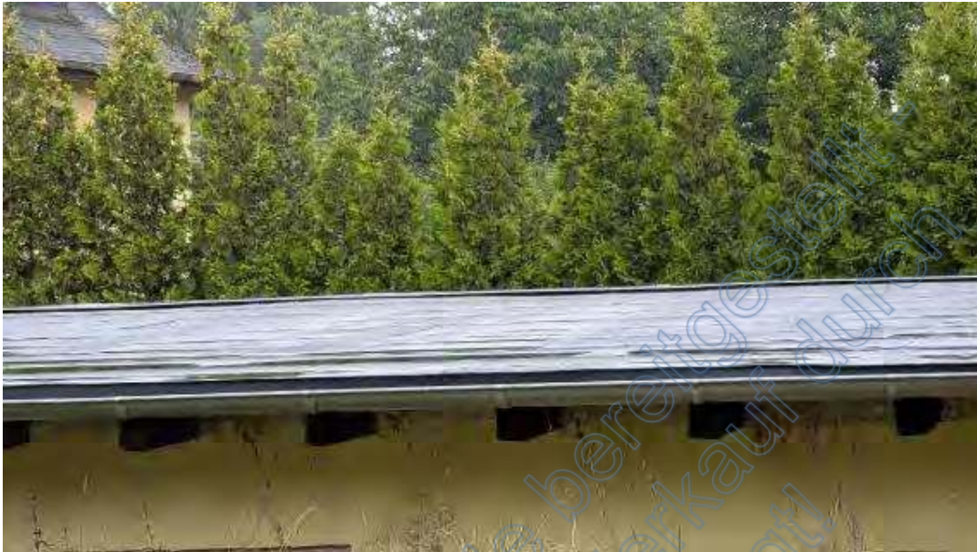
Bild B13 Teilausschnitt Dach Garage
