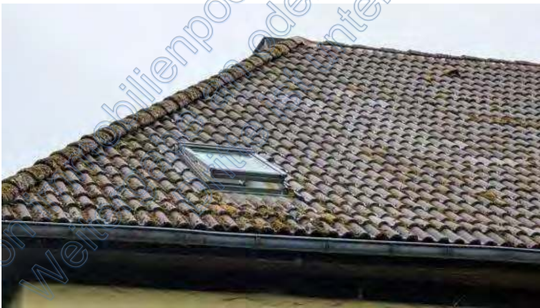
Bild B12 Teilausschnitt Dach Wohnhaus
