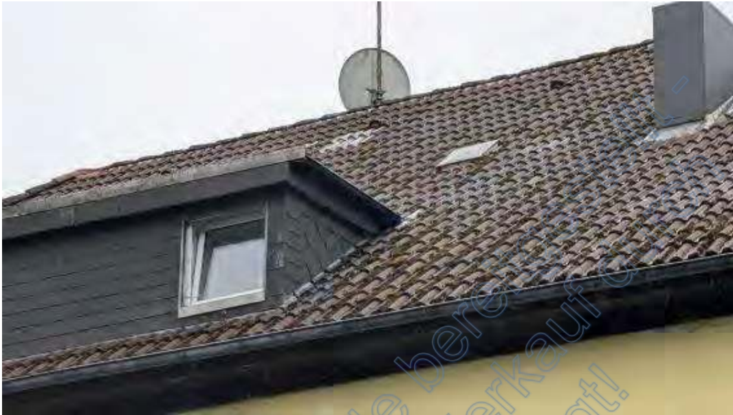
Bild B11 Teilausschnitt Dach Wohnhaus
