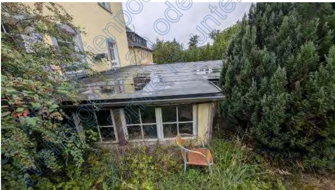
Bild B14 Teilausschnitt Dach Garage
