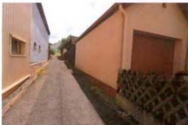
Foto 3: Gartenstraße Richtung Osten; rechts das Bewertungsgrundstück
