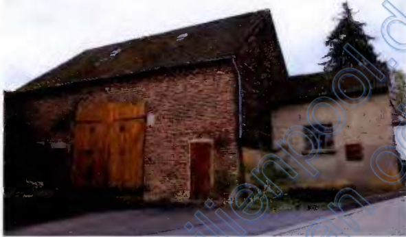
Bild 3: Scheune mit Anbau
