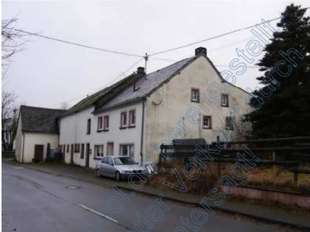
Bild 1: Straßen- und Seitenansicht
