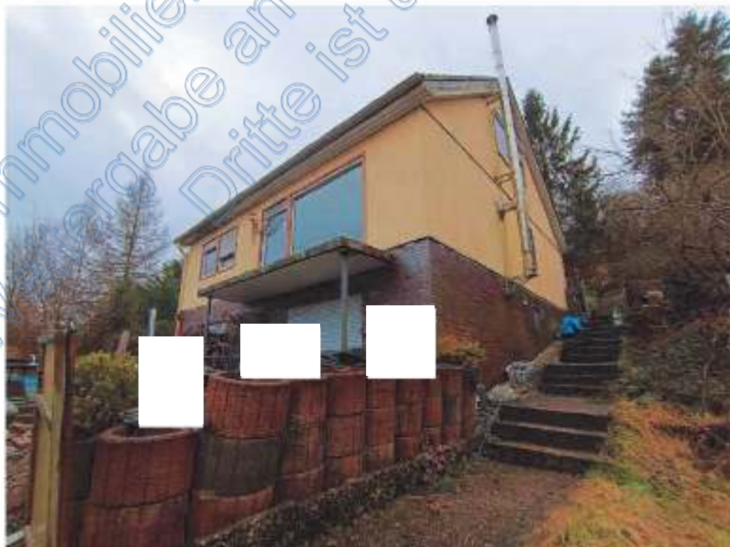
Bild 2: Straßen- und Seitenansicht
