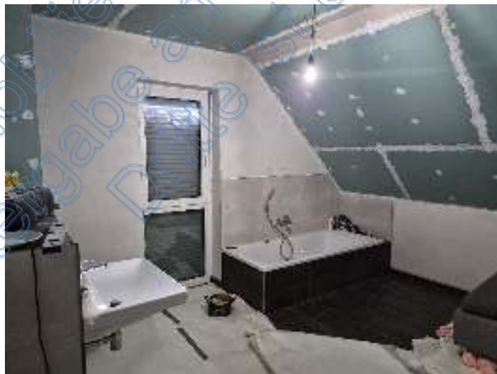
Bild 16: Innenansicht: des Bewertungobjektes, Bad im DG
