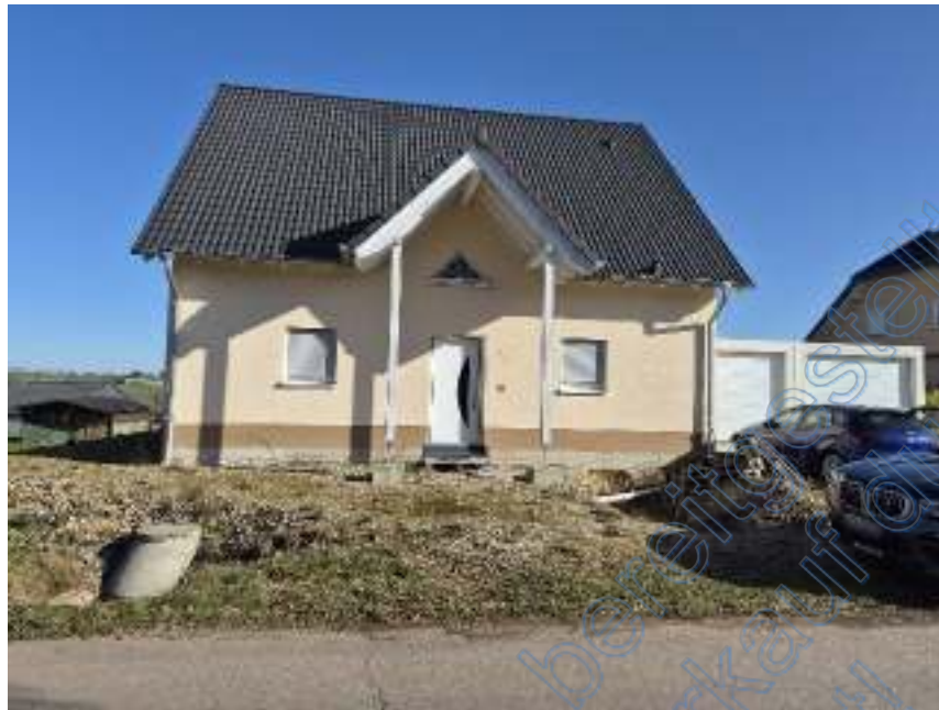
Bild 1: Straßenansicht des Bewertungsobjektes, aus südwestlicher Richtung
