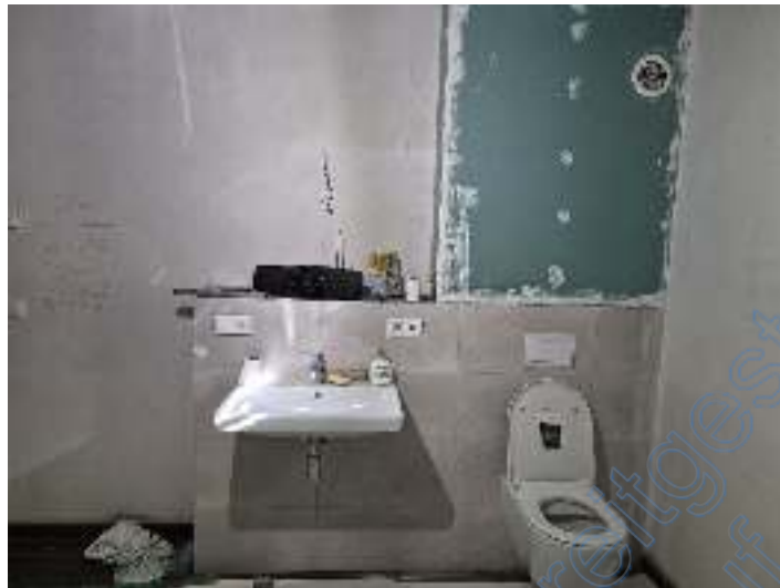
Bild 17: Innenansicht: des Bewertungsobjektes, Bad im DG
