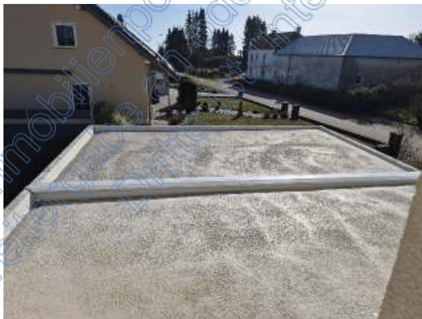
Bild 20: Dachaufsicht der Doppelgarage
