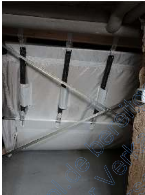
Bild 33: Innenansicht: des Bewertungsobjektes, hier Hauptgebäude, Pelletssilo im KG
