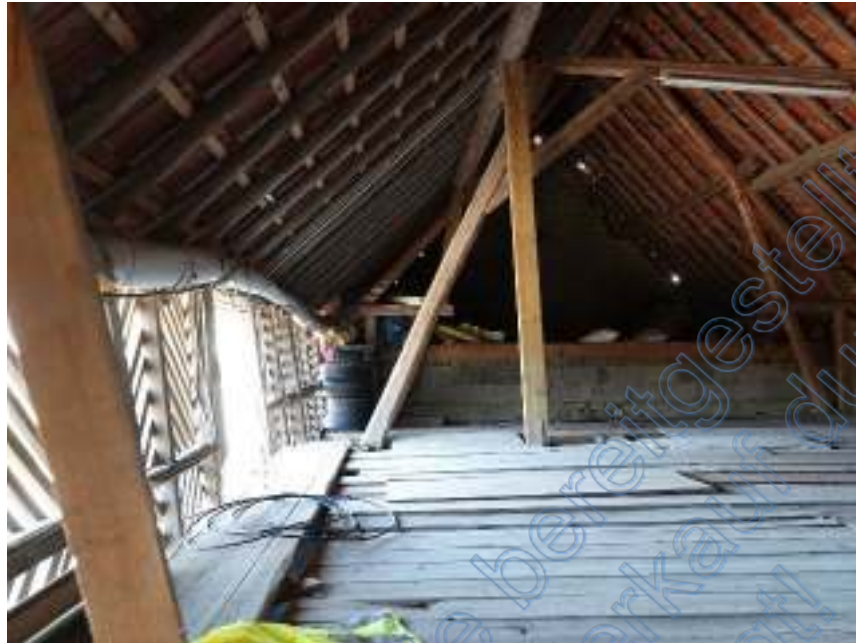
Bild 41: Innenansicht: des Bewertungsobjektes, hier Hauptgebäude, Dachraum über Garage/Lager
