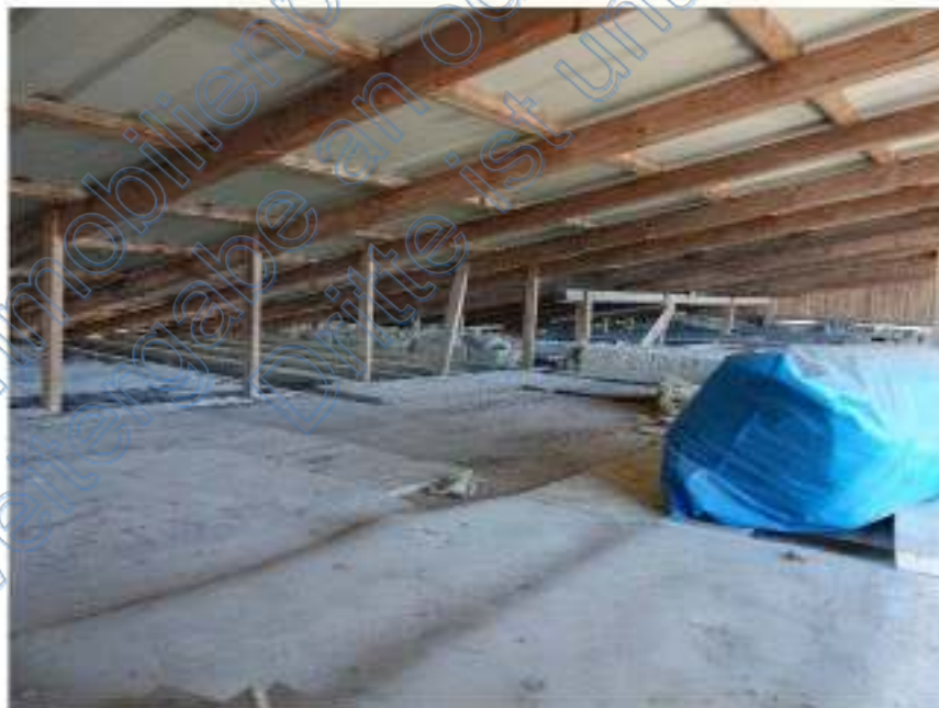
Bild 40: Innenansicht: des Bewertungsobjektes, hier Hauptgebäude, Dachraum über Garage/Lager
