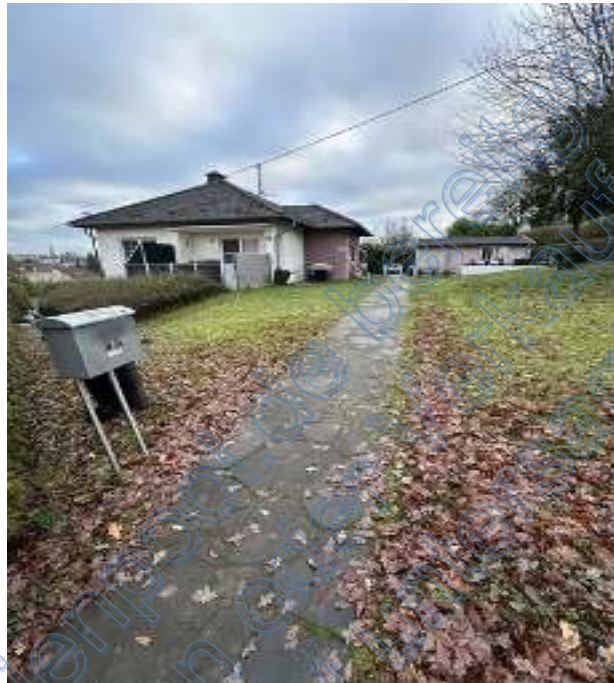
Freistehendes Einfamilienhaus Lerchenstraße 4A in 54634 Matzen
