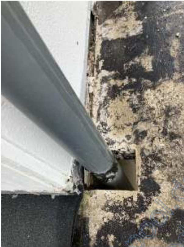
Bild 7 Draufsicht Fuge vor rechter Garage
