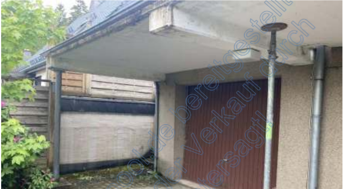
Bild 2 Auflagersituation linkes End- und Mittelauflager
