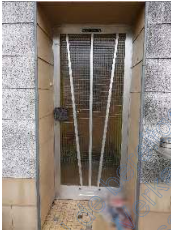
Bild 5: Giebelansicht des Bewertungsobjektes, aus nordwestlicher Richtung hier: Haus- eingang
