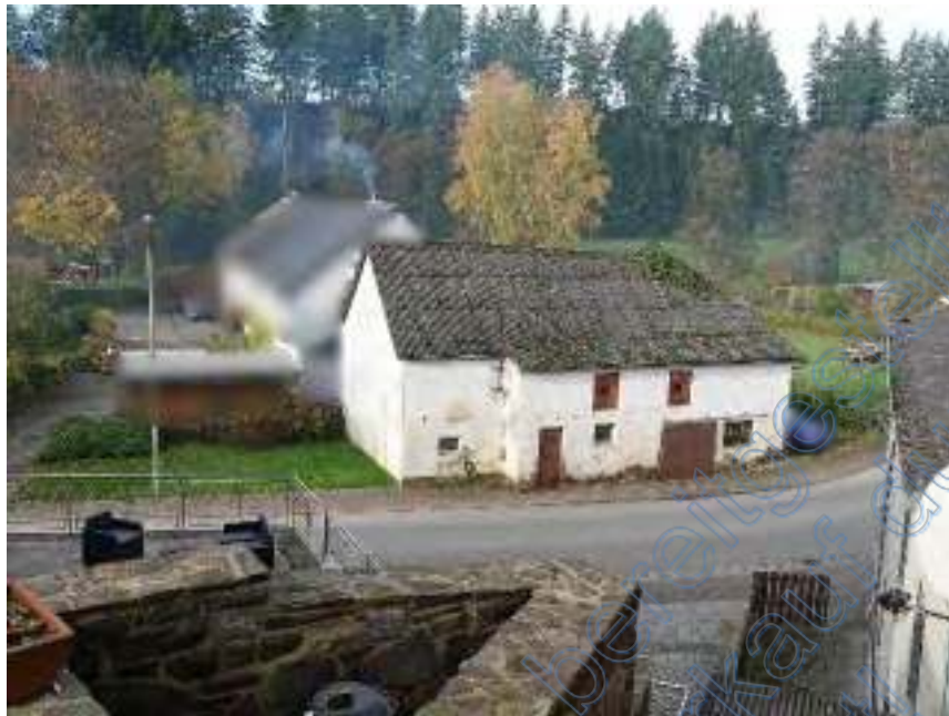
Bild 7: Ansicht Remise/Garage aus östlicher Richtung
