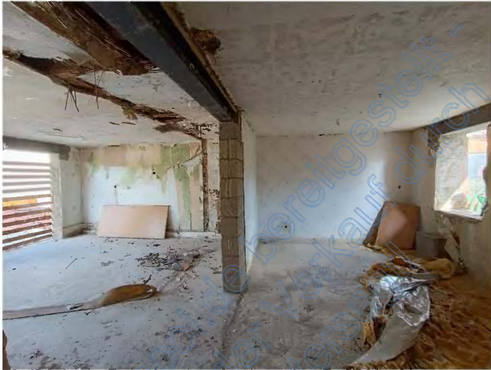
Bild 9: OG – Raum 1 und Raum 2
