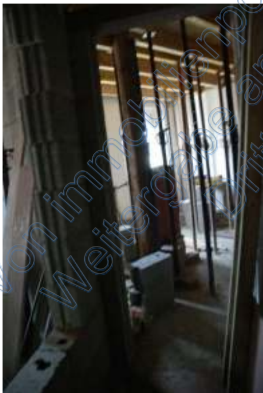
Innenansicht Flur, OG Decke komplett abgestützt
