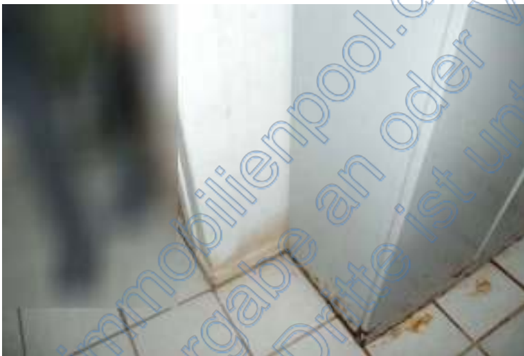
Detail Feuchtigkeitsschäden
