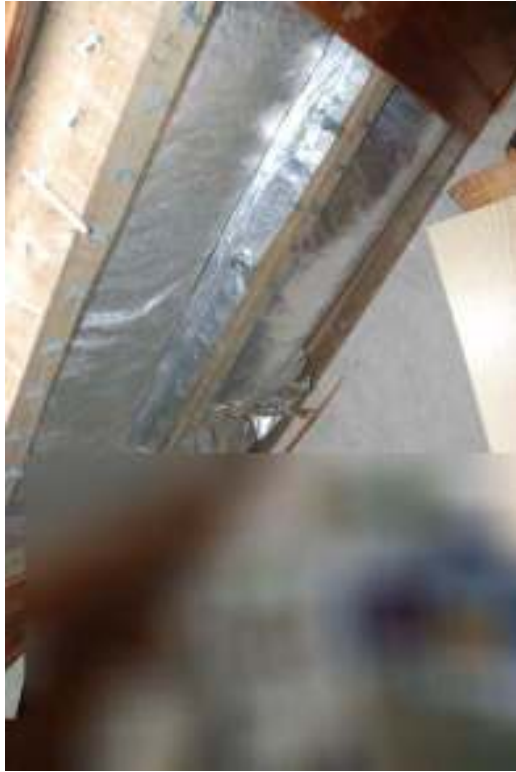
Detail fehlende Verkleidung
