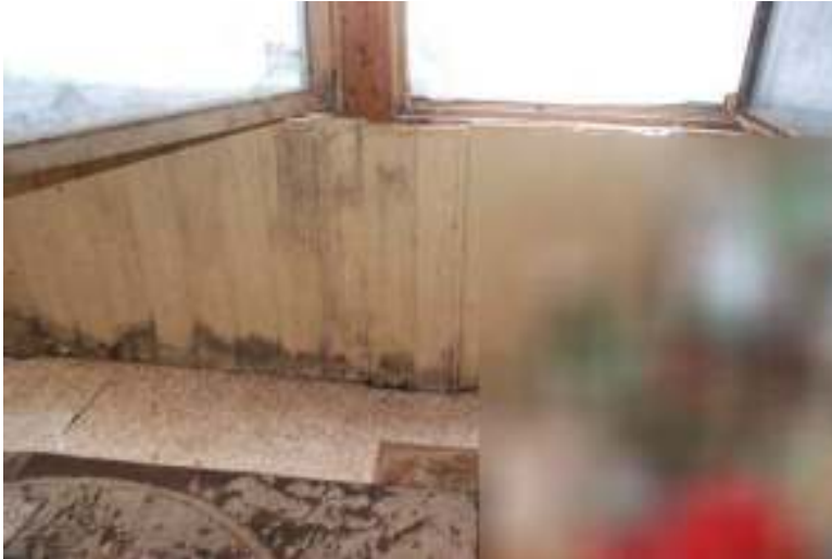
Detail Feuchtigkeitsschäden
