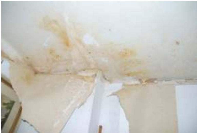
Detail Feuchtigkeitsschäden, Tapete löst sich
