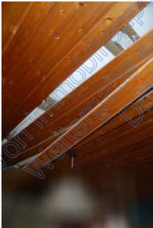
Detail Decke, Verkleidung löst sich
