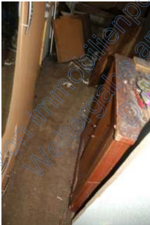
Detail Fußboden, Feuchtigkeitsschäden durch Löschwasser bei Brand vom Dachstuhl im Nachbargebäude
