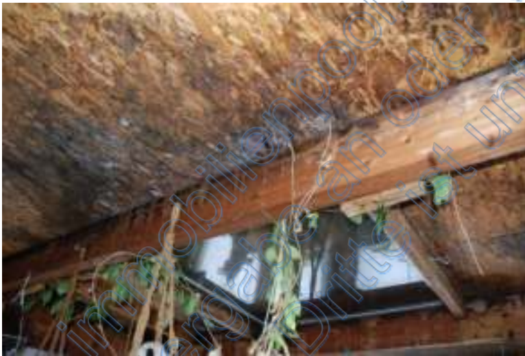
Detail Dach, undicht, Feuchtigkeitsschäden
