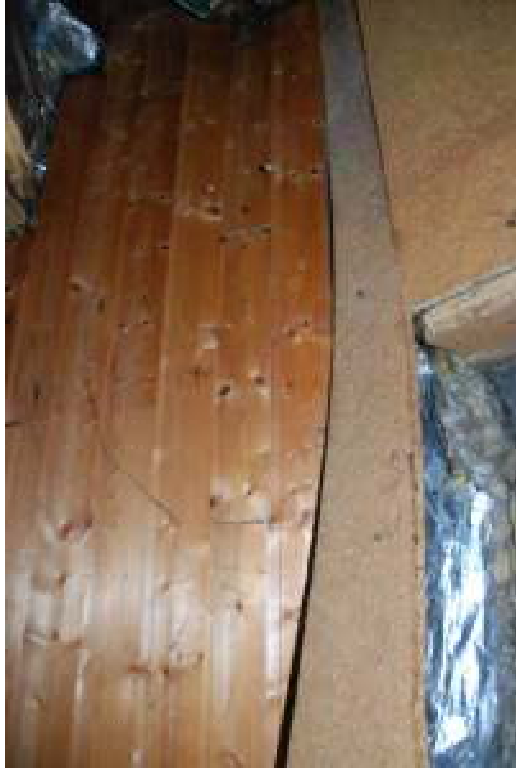
Detail Dachschräge, Nut- und Federbretter teilweise entfernt
