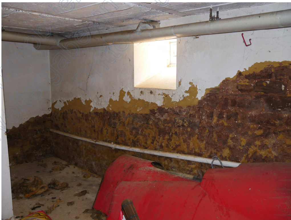
Bild 6: KG Wohnung 1 – Kellerraum
