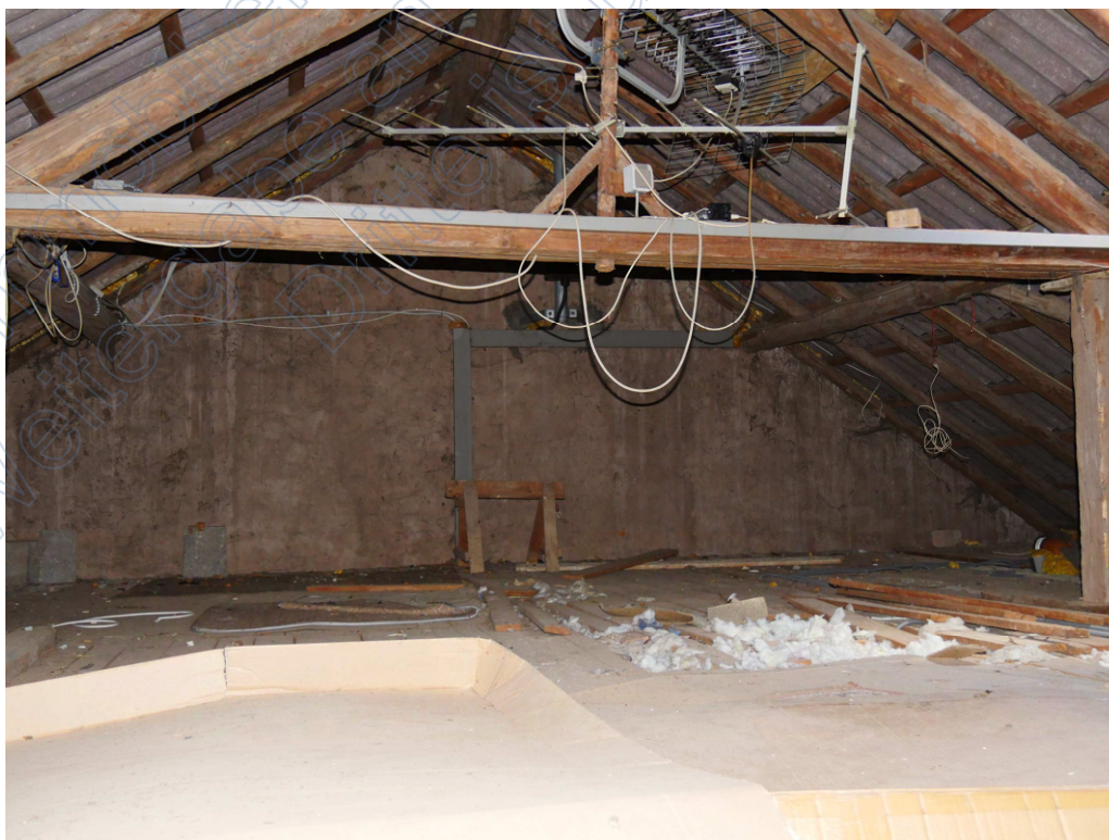
Bild 16: DG Wohnung 2 – Speicher
