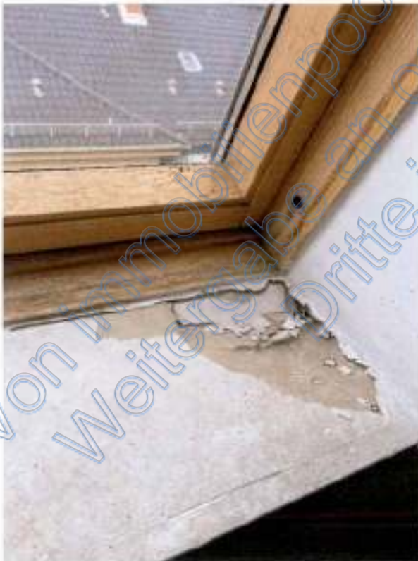
Abbildung 22: Defekte Dachfensterinnenbekleidung.
