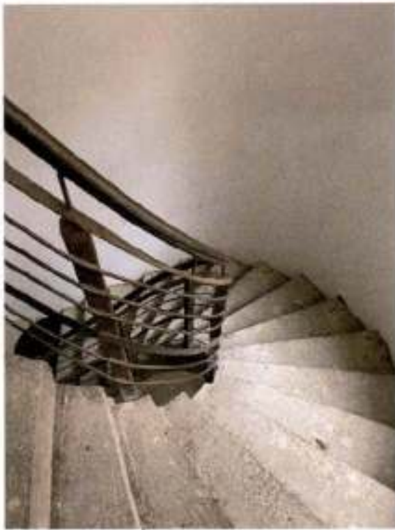
Abbildung 15: Wendeltreppe im Treppenhaus.
