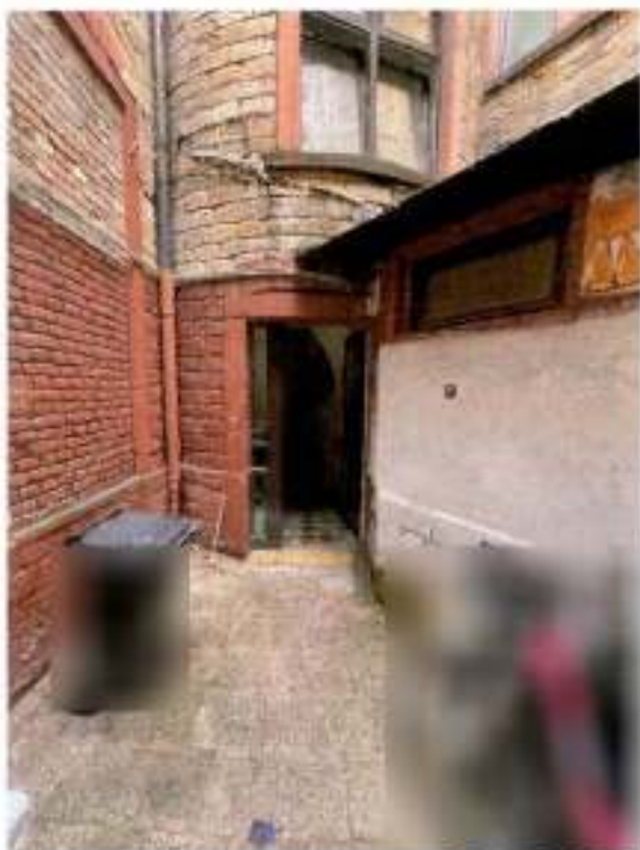
Abbildung 13: Innenhof zum Hauseingang.
