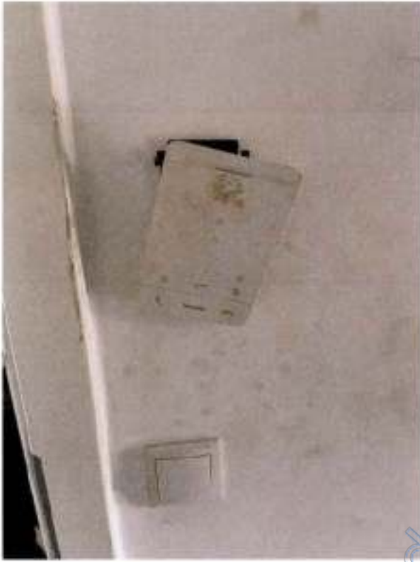
Abbildung 21: Defekte Sprechanlage.
