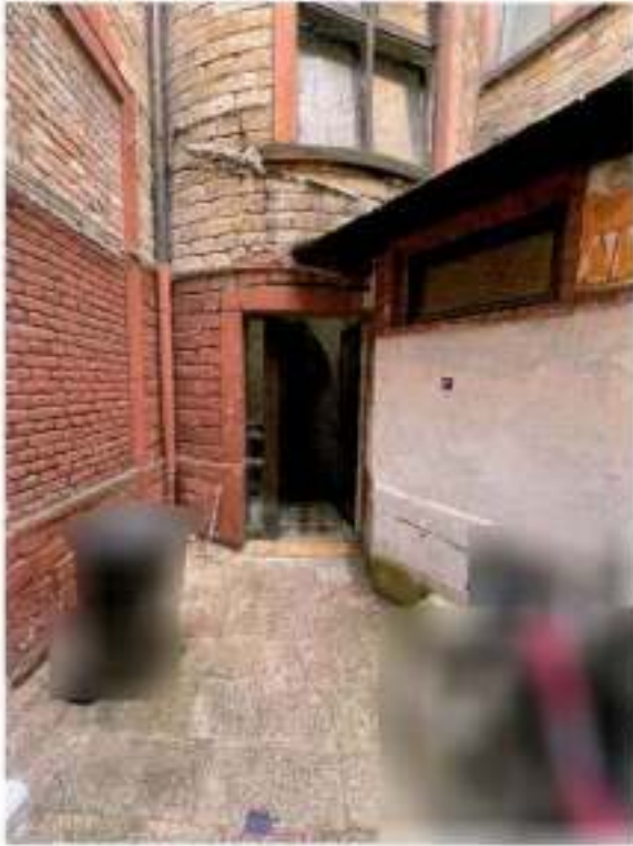
Abbildung 13: Innenhof zum Hauseingang.
