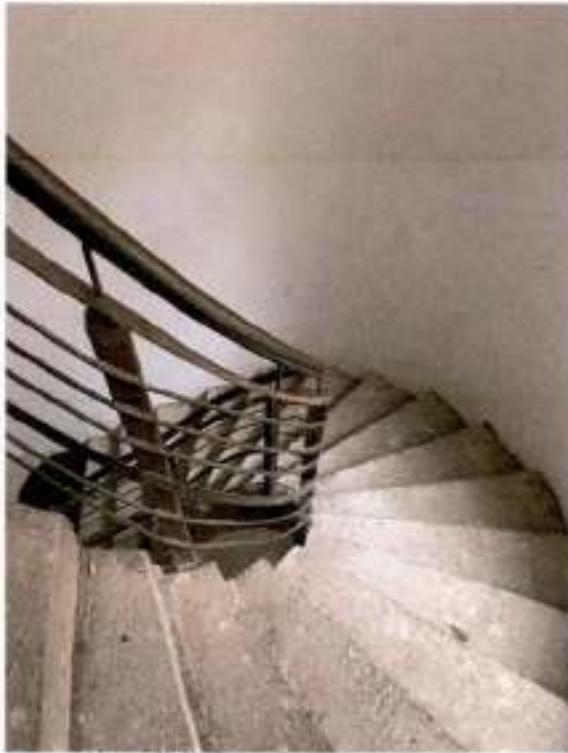
Abbildung 15: Wendeltreppe im Treppenhaus.
