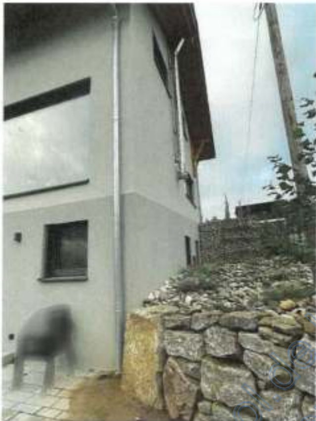
Seitenansicht, zusätzlicher Kamin
