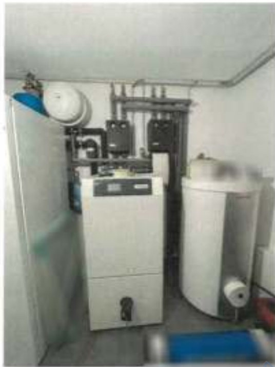
Heizungsanlage, Erdwärmepumpe
