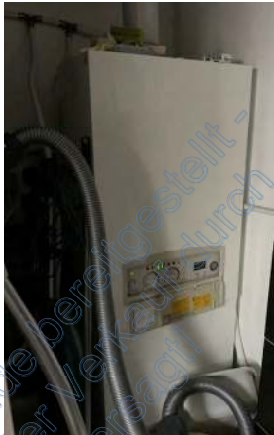
Heizungstherme, Gas, DG
