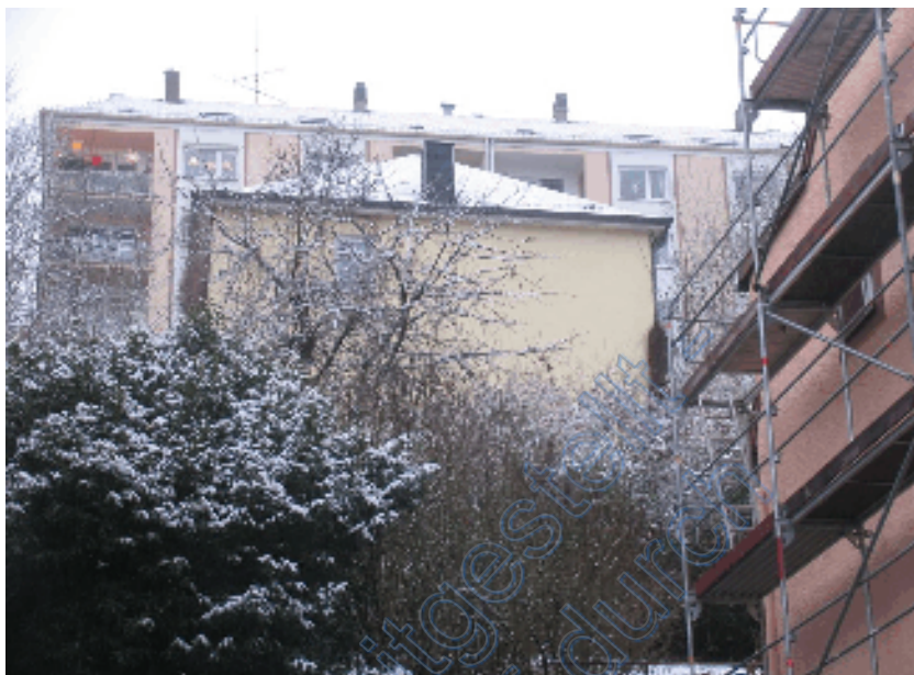
Blick von der Zeppelinstrasse aus auf das Gebäude des Flurstücks Nr 5790/3
