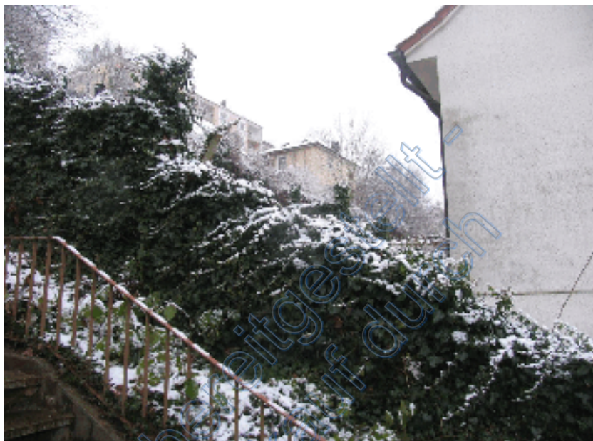
Blick vom Treppenweg auf das Gebäude des Flurstücks Nr. 5790/3
