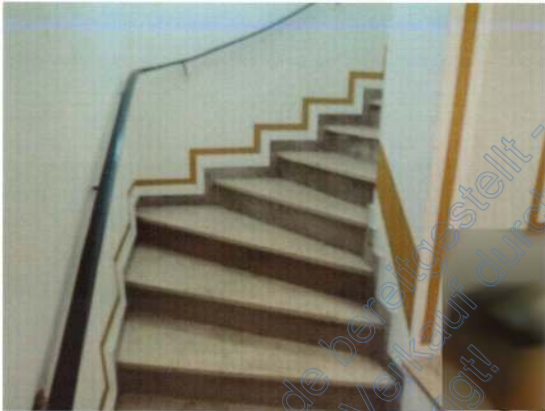
Treppenaufgang zum OG
