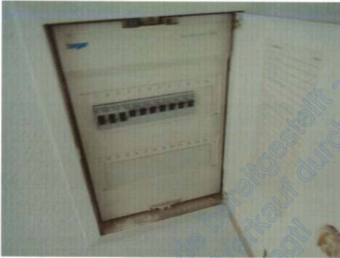
Sicherungskasten
